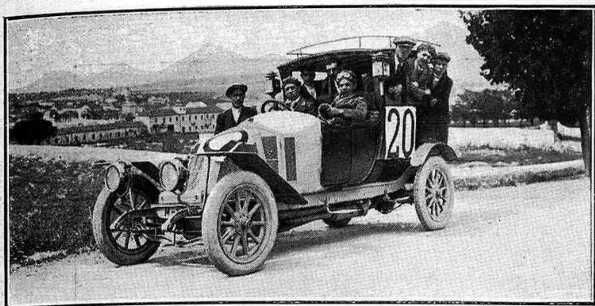
(1) 14 HP., 82 X 140, con 1.808 kilos, con ocho asientos, gana Medalla de Oro en el Concurso de Navacerrada. — (2) 12 HP., 75 X 130, con 1.437 kilos sube al puerto de Guadarrama en doce minutos cincuenta segundos y el de Navacerrada en 25 minutos. — (3) 26 HP., tipo "SPORT", 96 X 190, con 1.572 kilogramos subió en el Concurso de Navacerrada en diez y seis minutos seis segundos; 5.º de la clasificación general. Sube a Guadarrama en cuatro minutos, cincuenta y ocho segundos.
