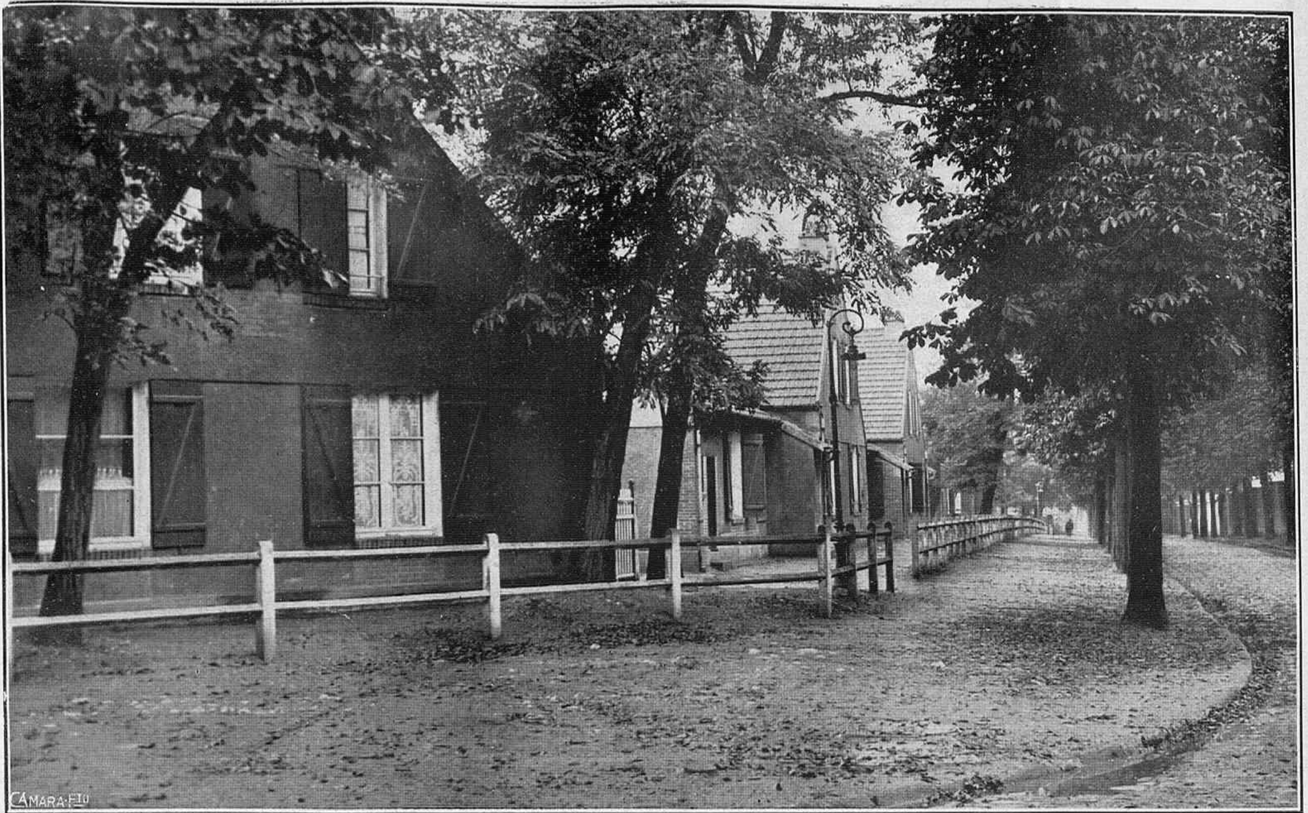
Los pabellones de la «Cité Jardin de Dugny» (Fot. Vidal)
