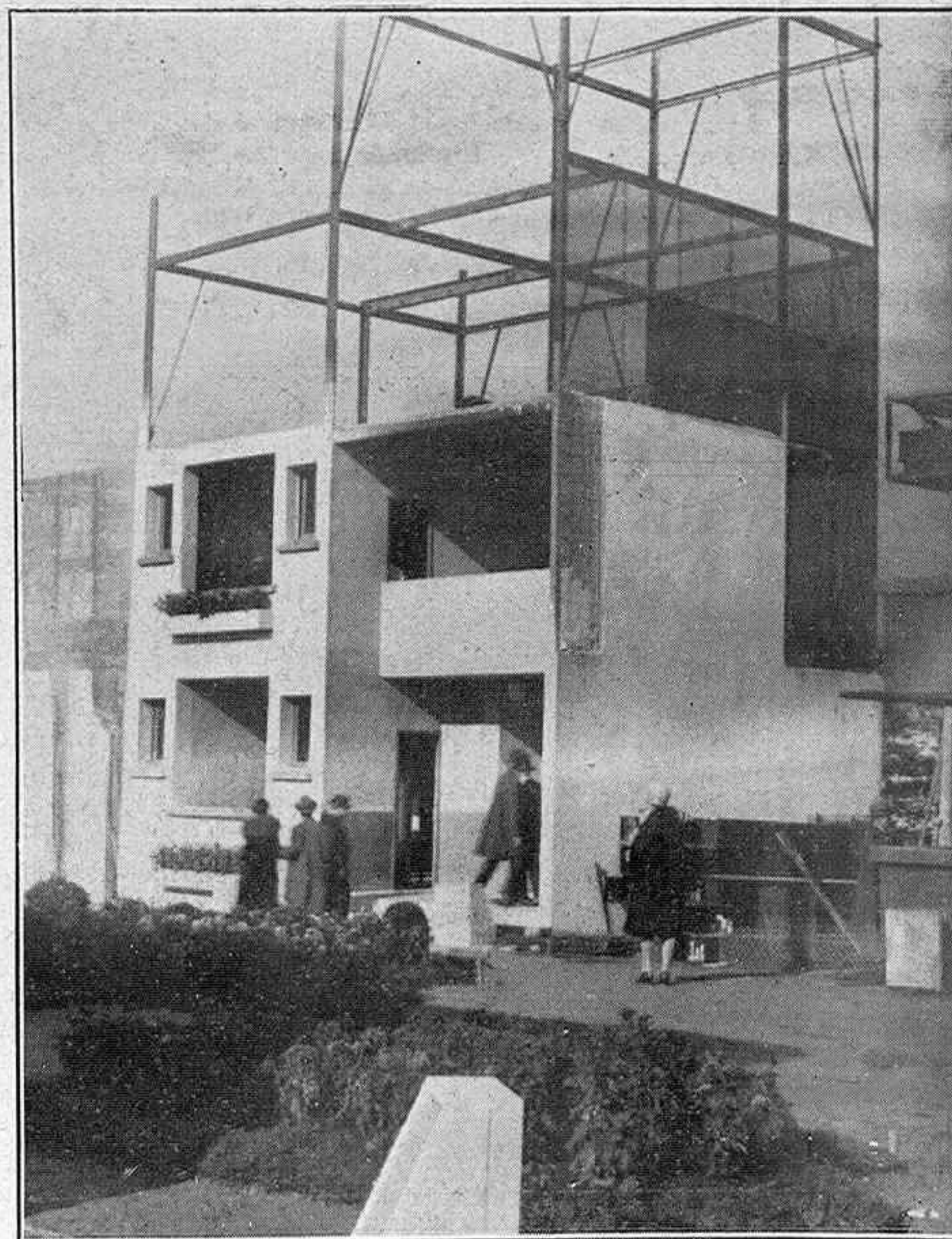
Modelo de casa económica con armadura de hierro (Fot. Orrios)
