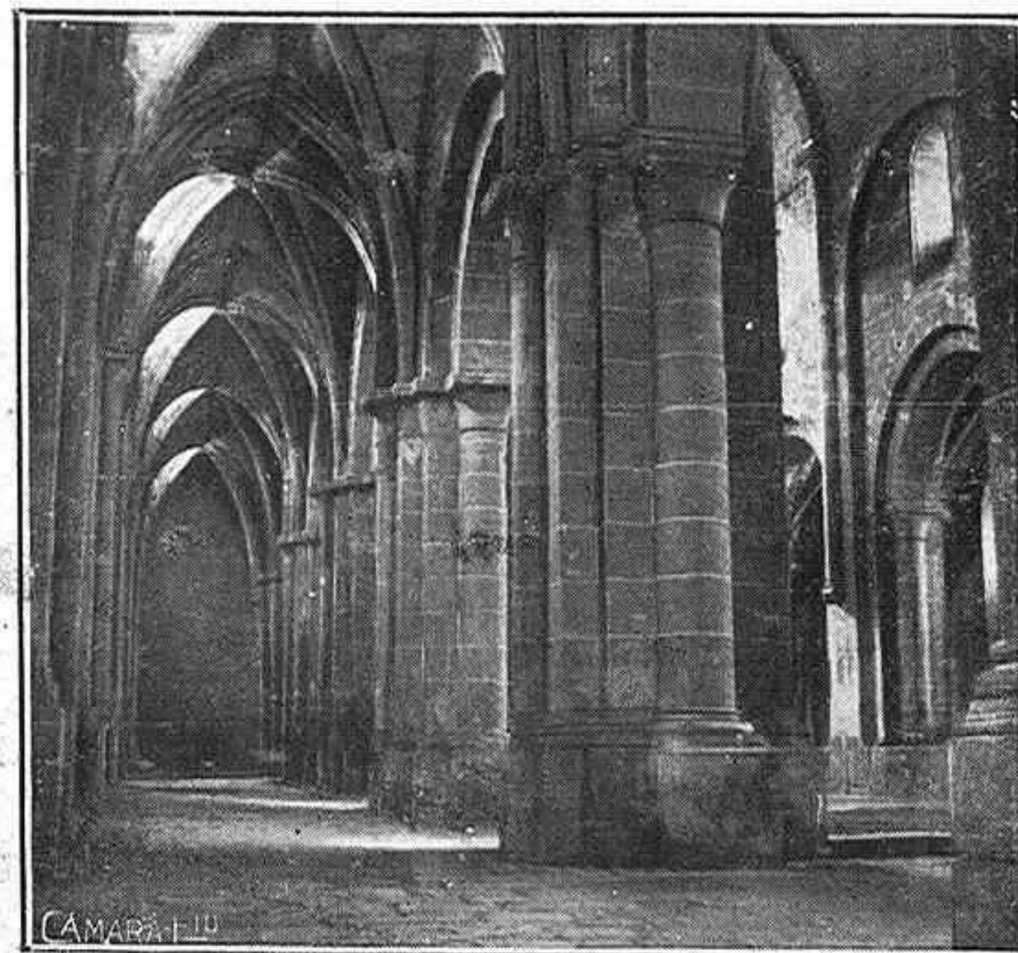
Nave lateral de la Basílica
