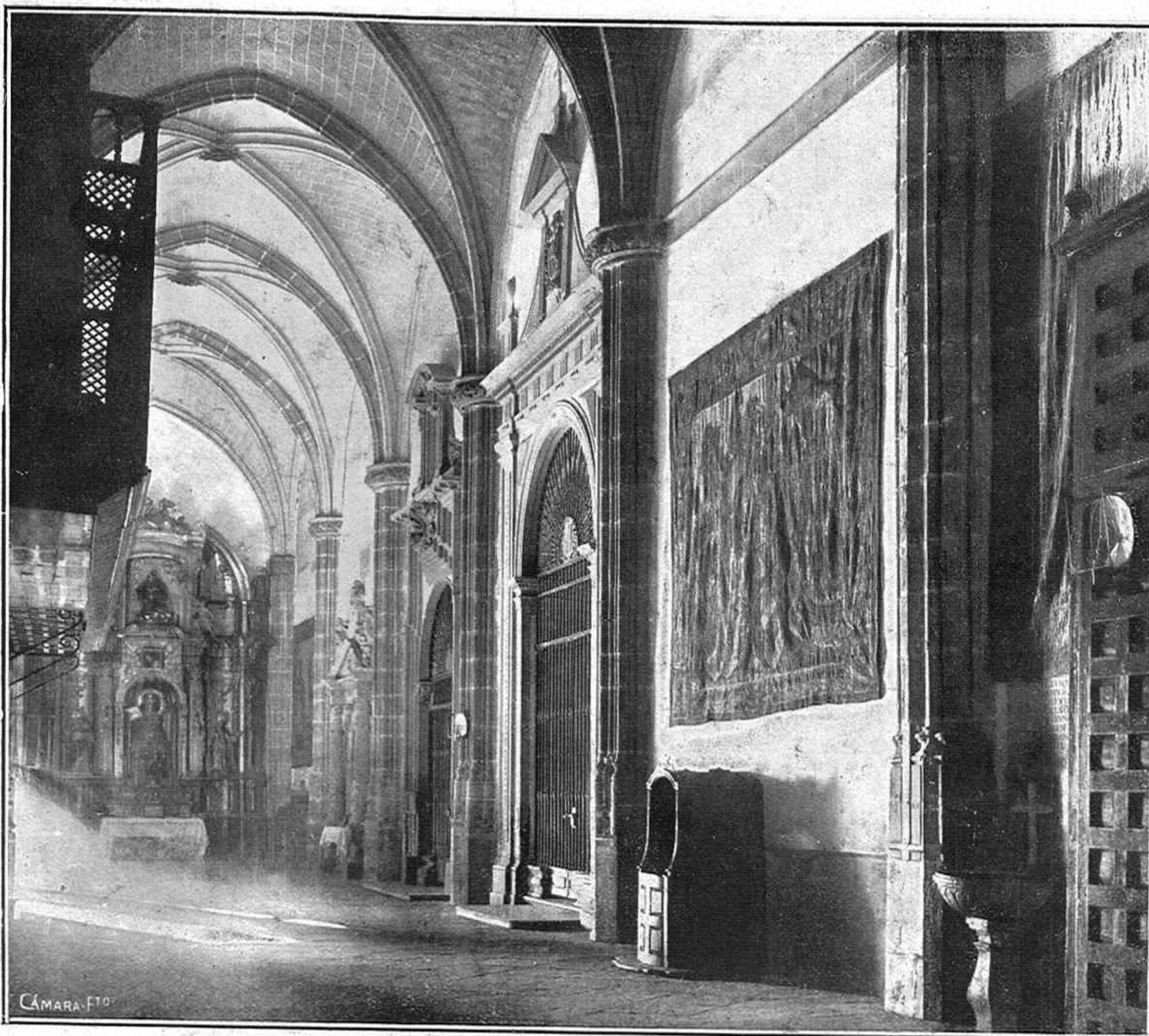
Interior de la Colegiata, actualmente en restauración
