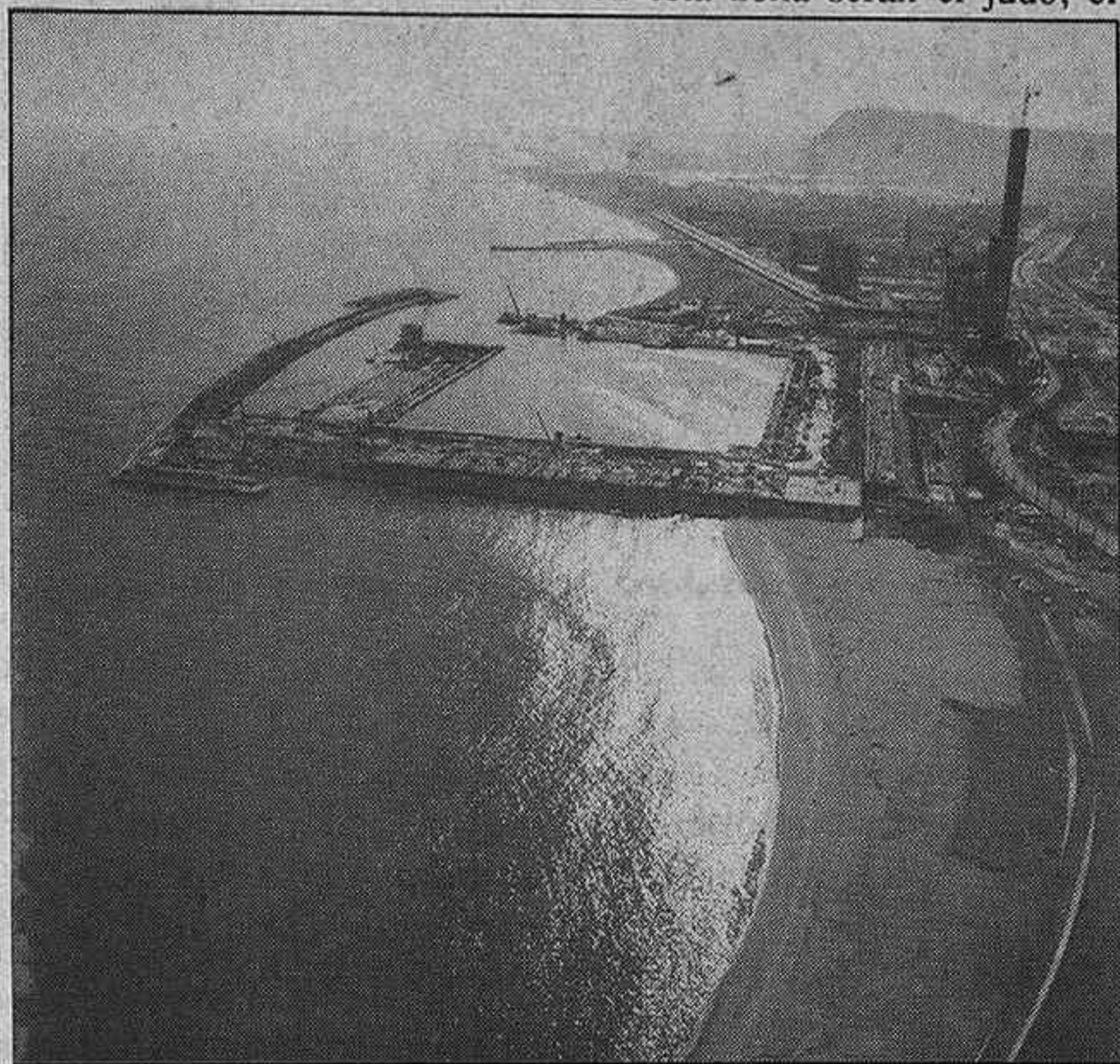
Vista general de las obras en el puerto olímpico. La vela es el único deporte con posibilidades de una participación alcarreña si finalmente el "Guadalajara Puerta Abierta" de Plaza y Gutiérrez consiguiera su clasificación.
