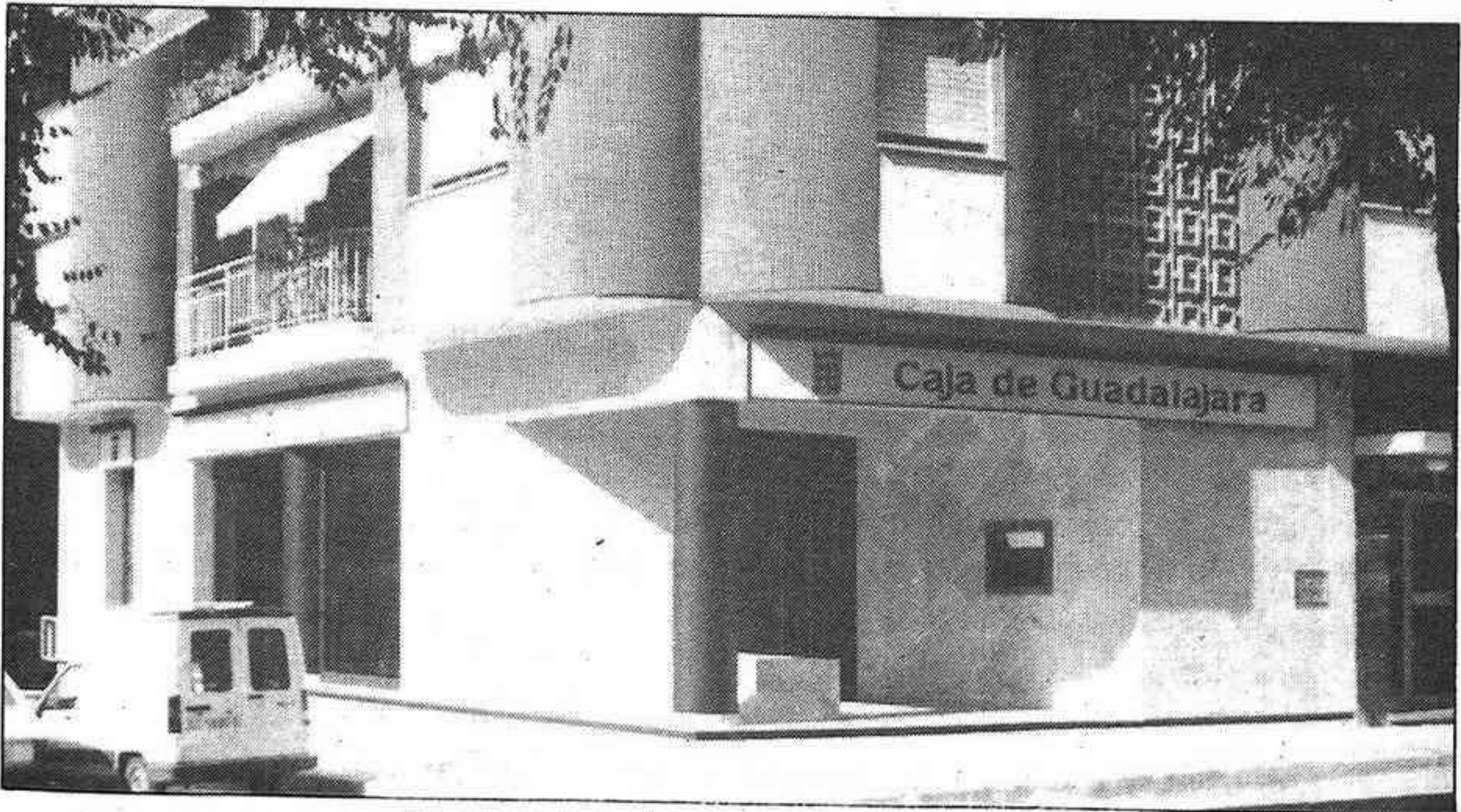
Aspecto exterior de la nueva Oficina Urbana, 10
