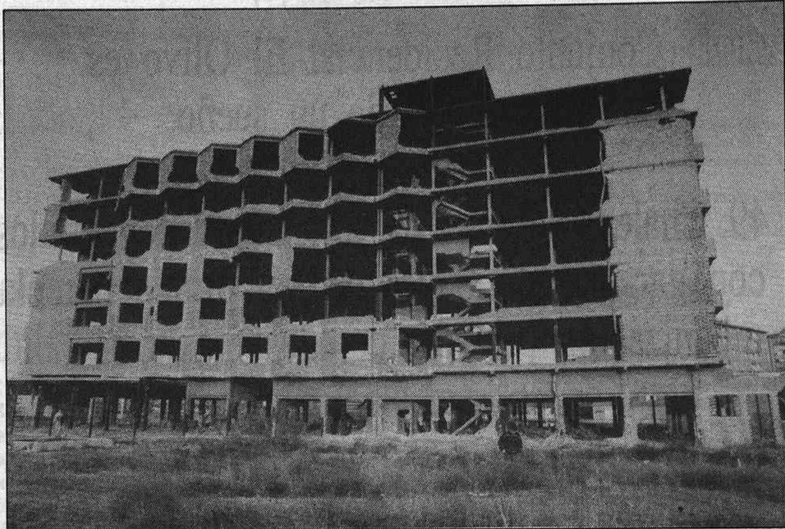
La estructura del fallido "Alcarria Palace" será demolida y allí se levantará el hipermercado
