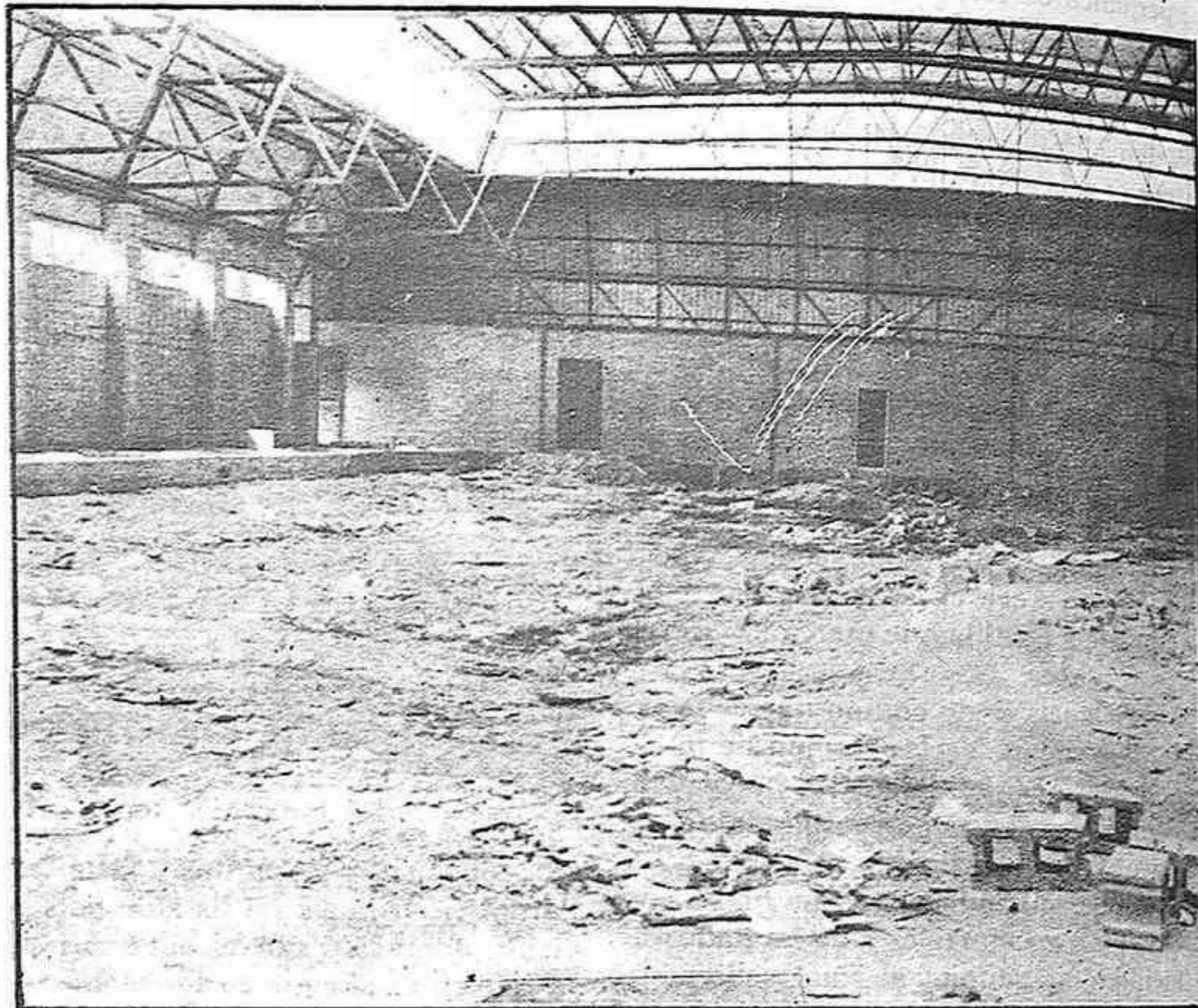
Falta por realizar el interior, que ocupa la 2ª fase
