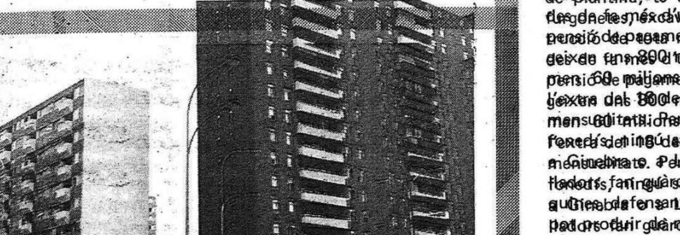
Una obra de construcció a Ciutat Badia.
