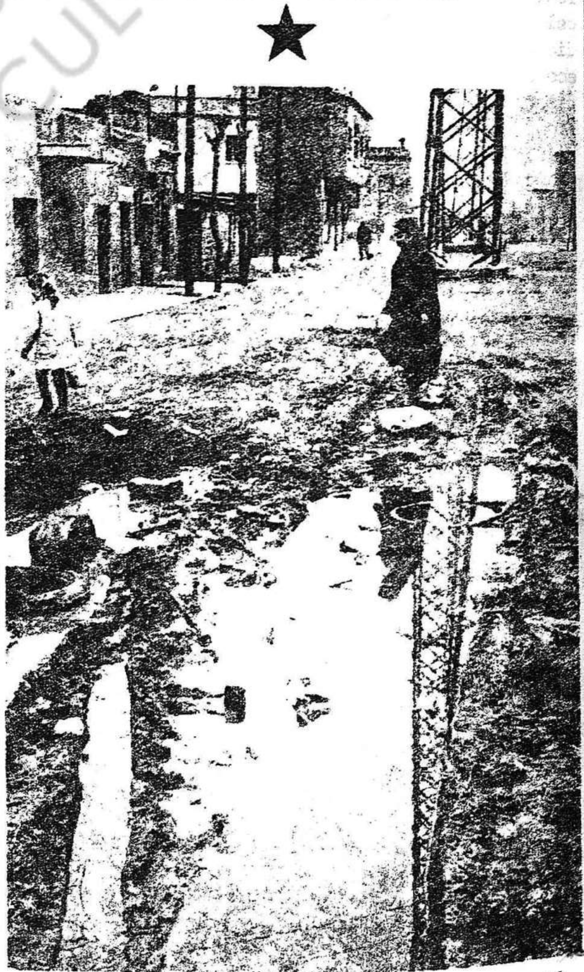
Carrers sense pavimentar, fang, cables d'alta tensió sense protecció, manca d'aigua corrent a les cases, etc., es una panoràmica del barri "La Catalana".
