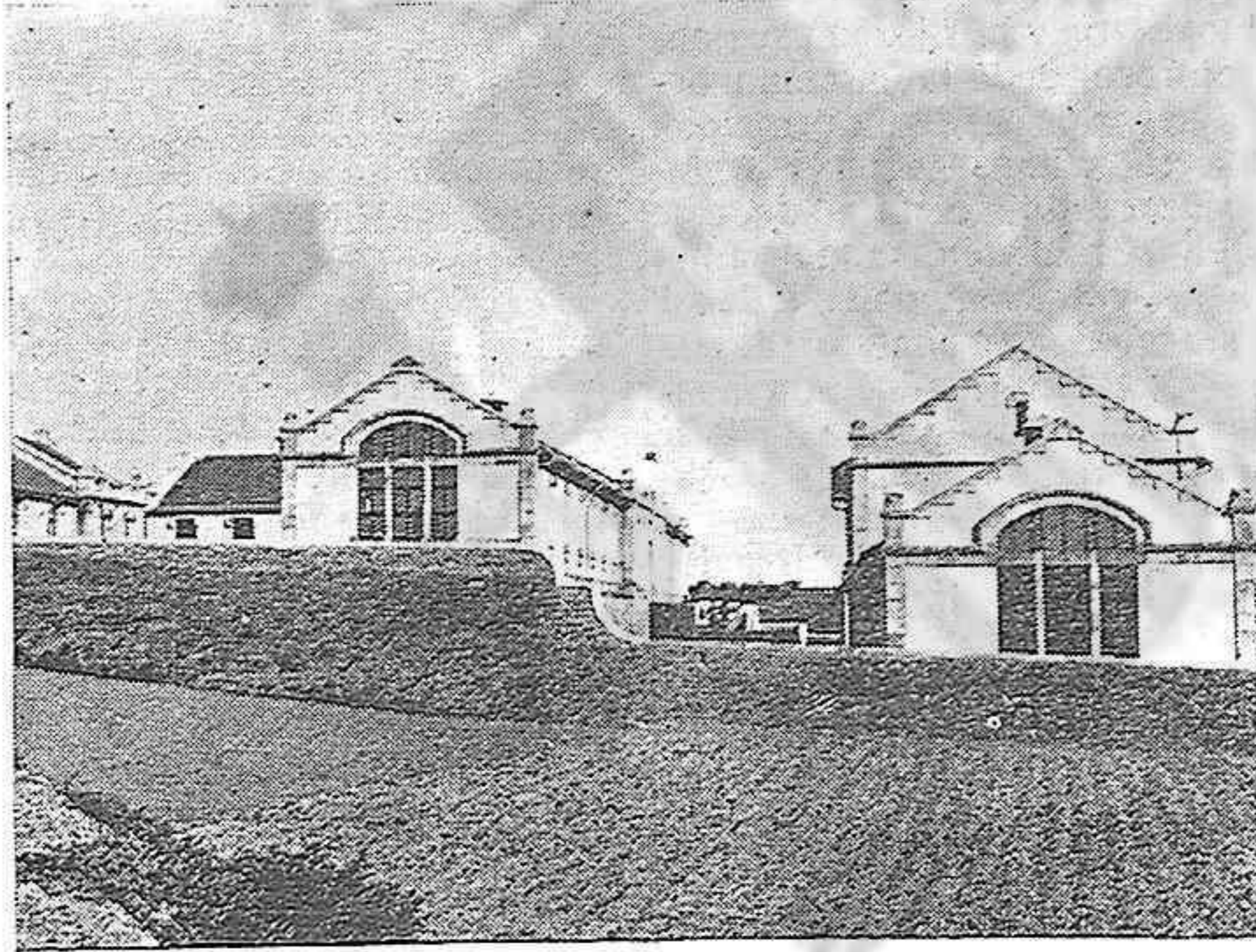
Vista de algunos pabellones
