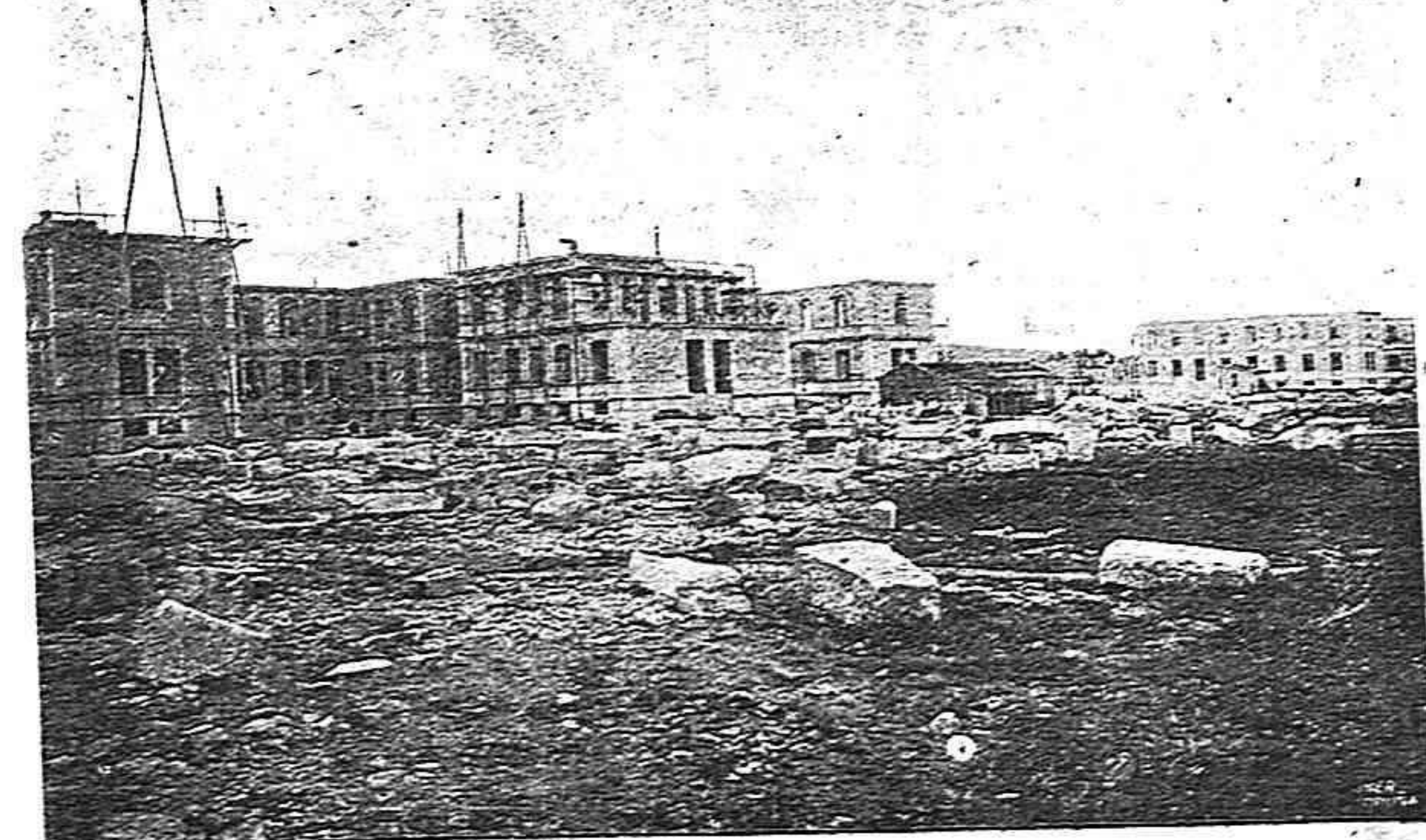
Escuela de Sordo-mudos y ciegos, de Santiago, en construcción.
