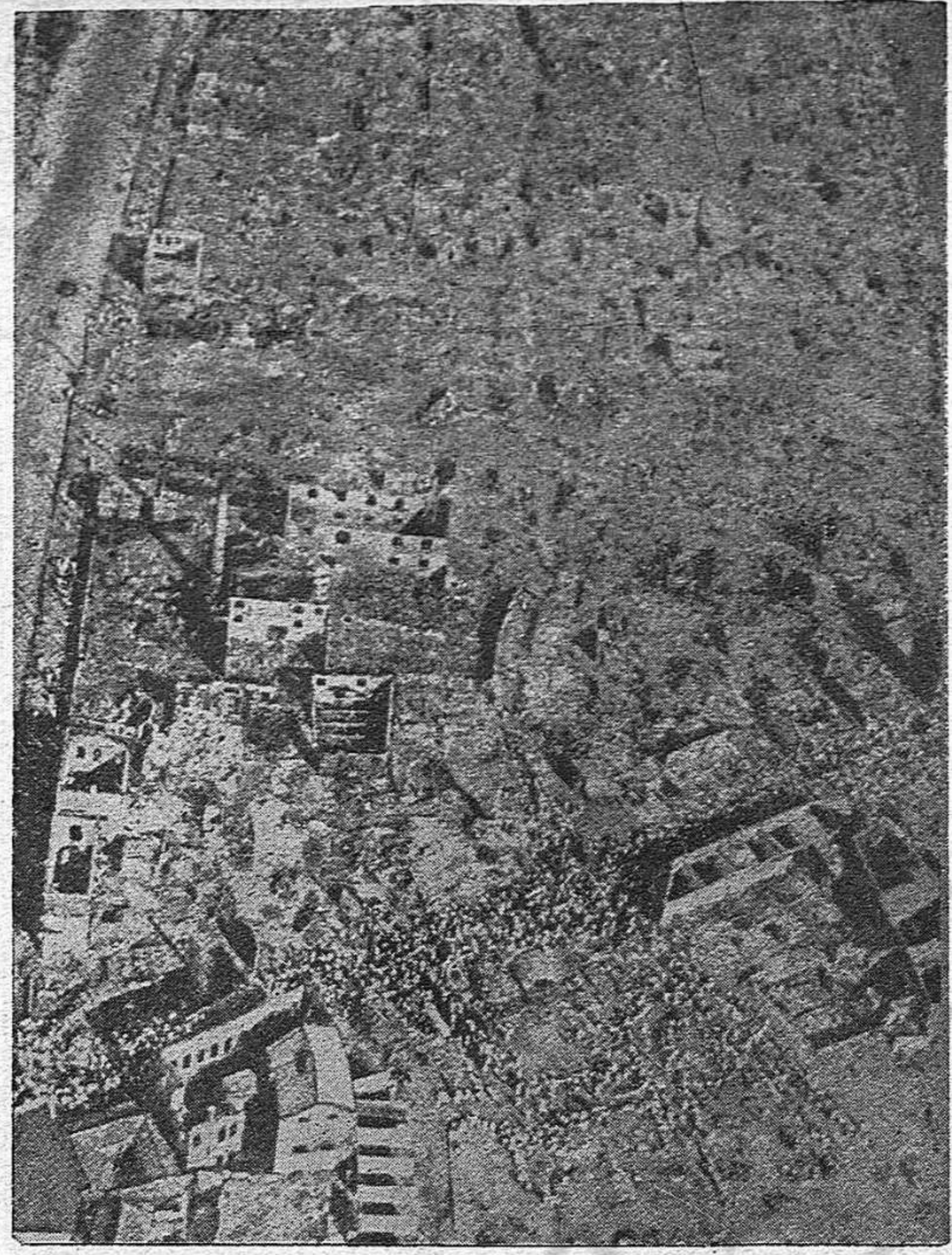
Pasaron los aviones invasores yanquis, y esto queda hoy de lo que fuera una pacífica ciudad coreana. La impotencia ante el heroísmo se traduce en provocaciones salvajes.
