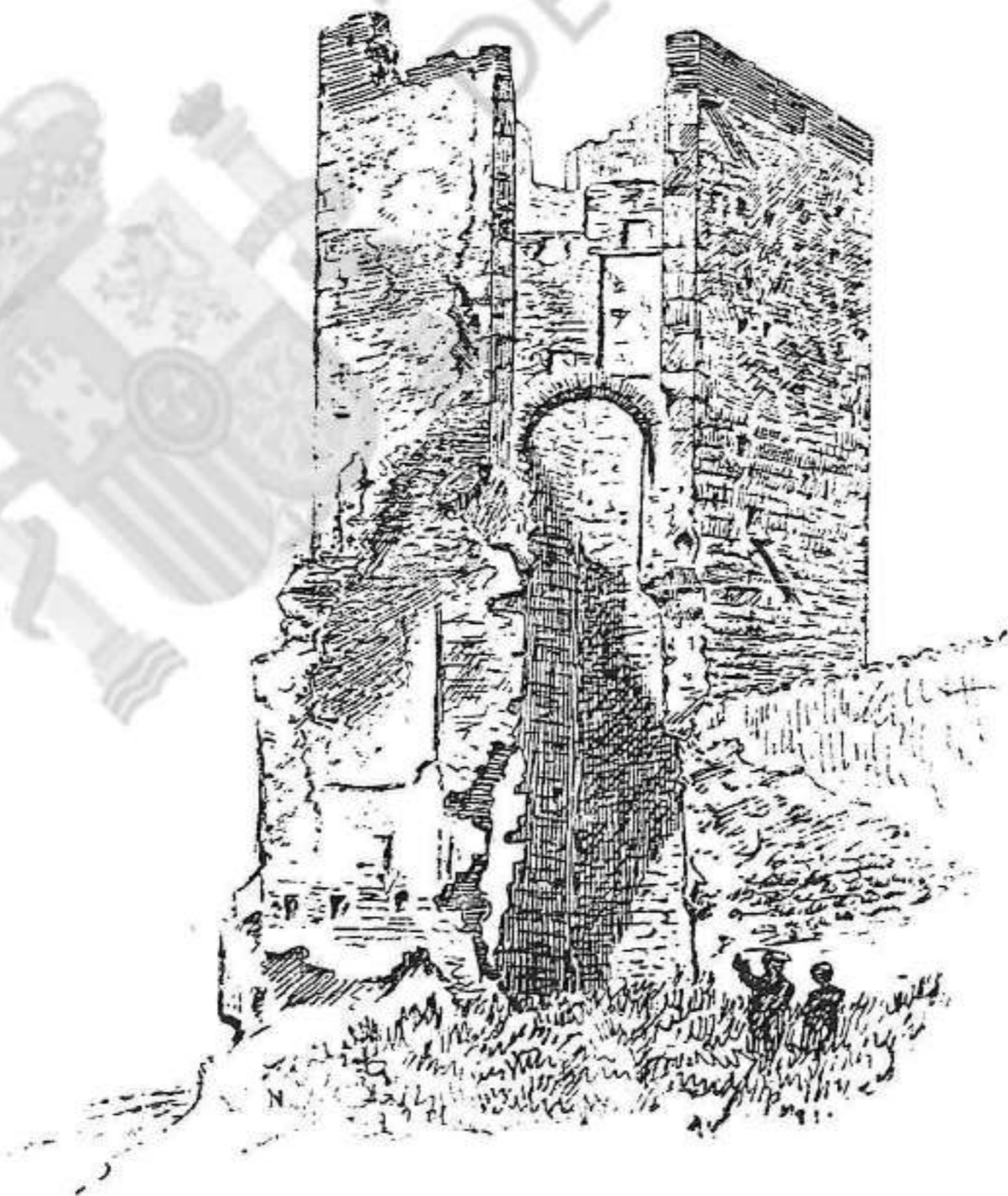
Restos de la muralla
