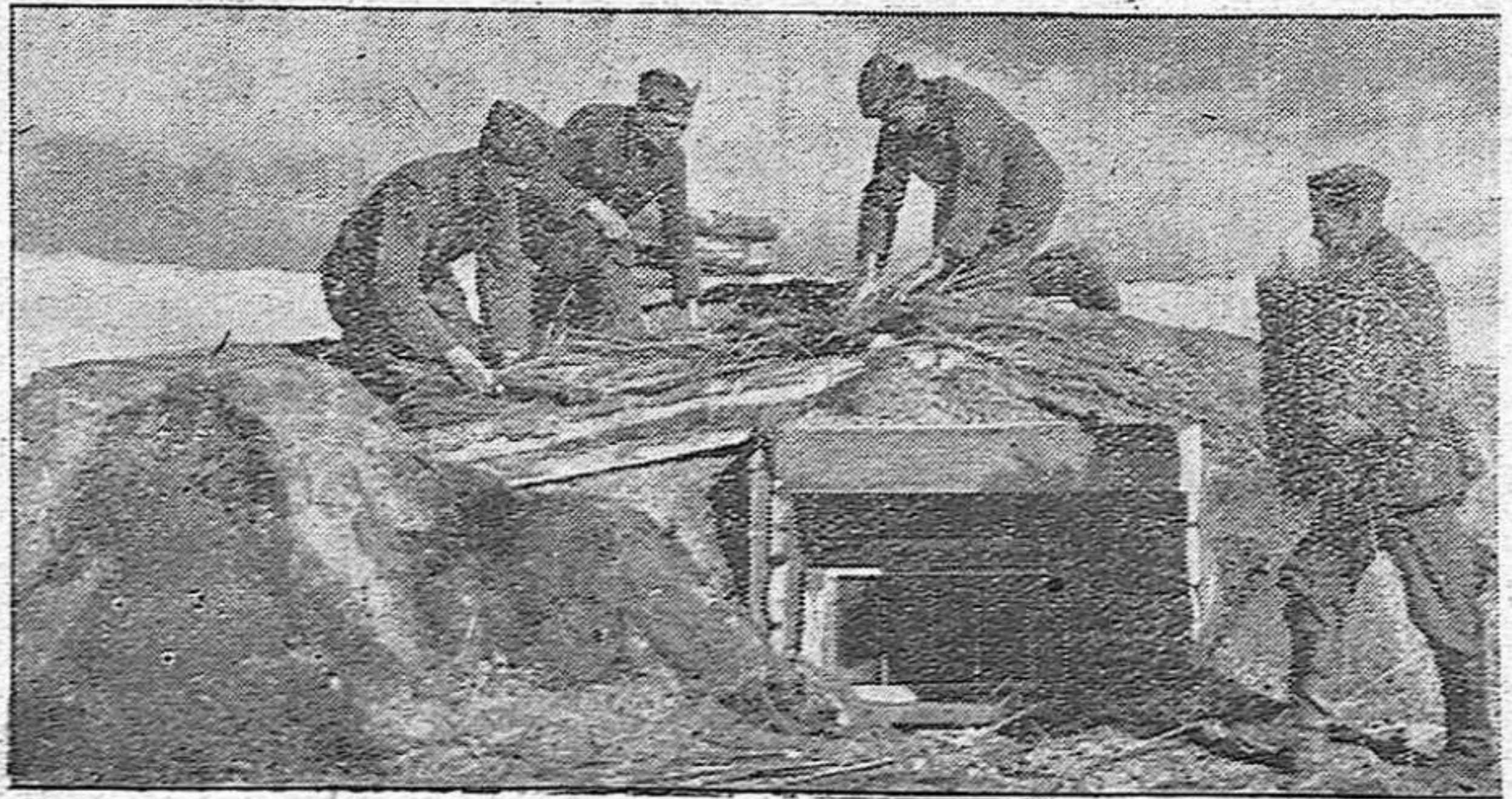
Hombres del servicio de Trabajo alemán construyendo refugios para los soldados en Rusia. El techo es cubierto de paja y arena y se deja la entrada lo más pequeña posible, para que no entre la nieve.
