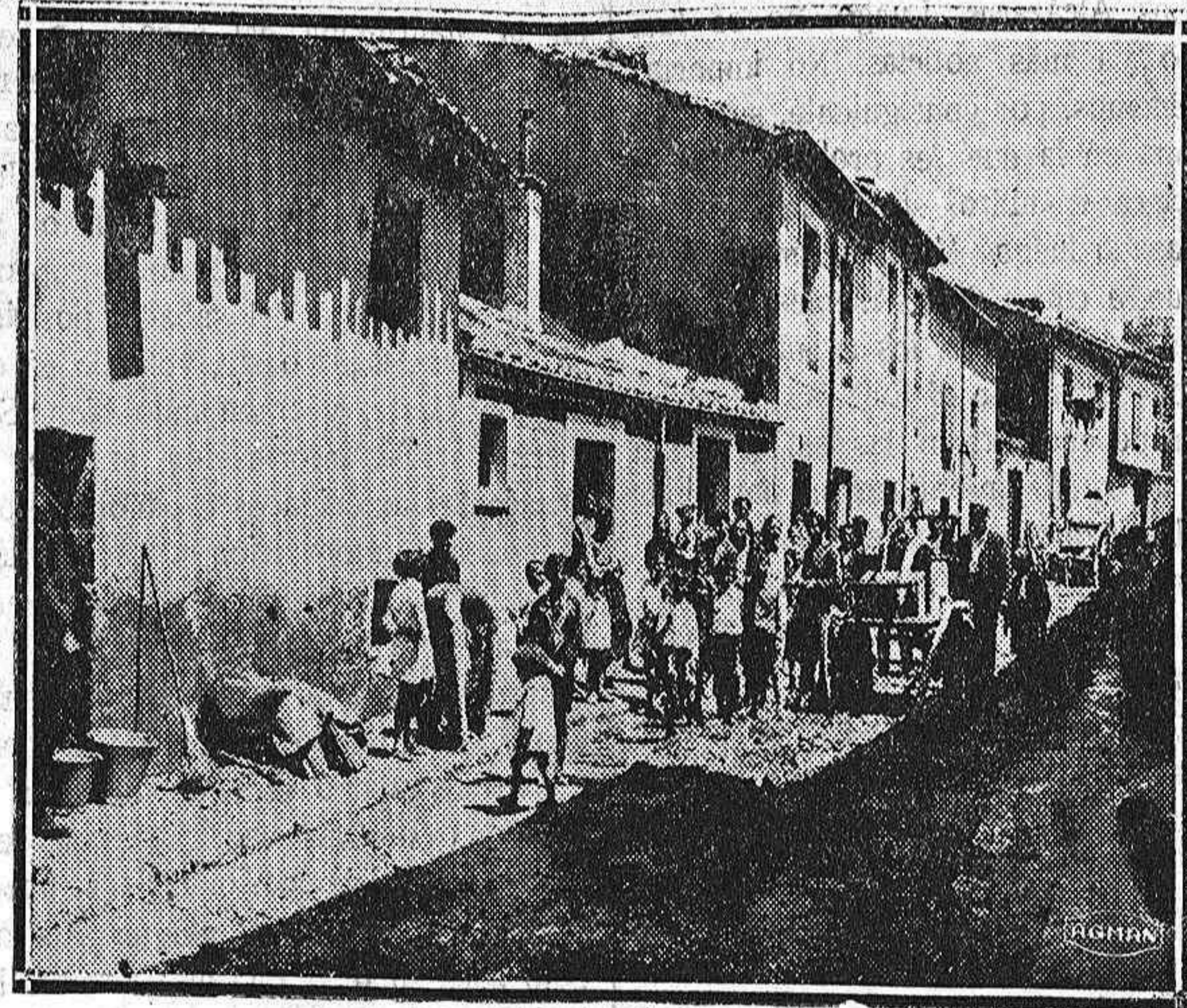
Después de la tormenta.—Los bomberos trabajan activamente en desalojar el agua de las casas, en la calle de los Gatos. (Foto Guzmán do Rego)
