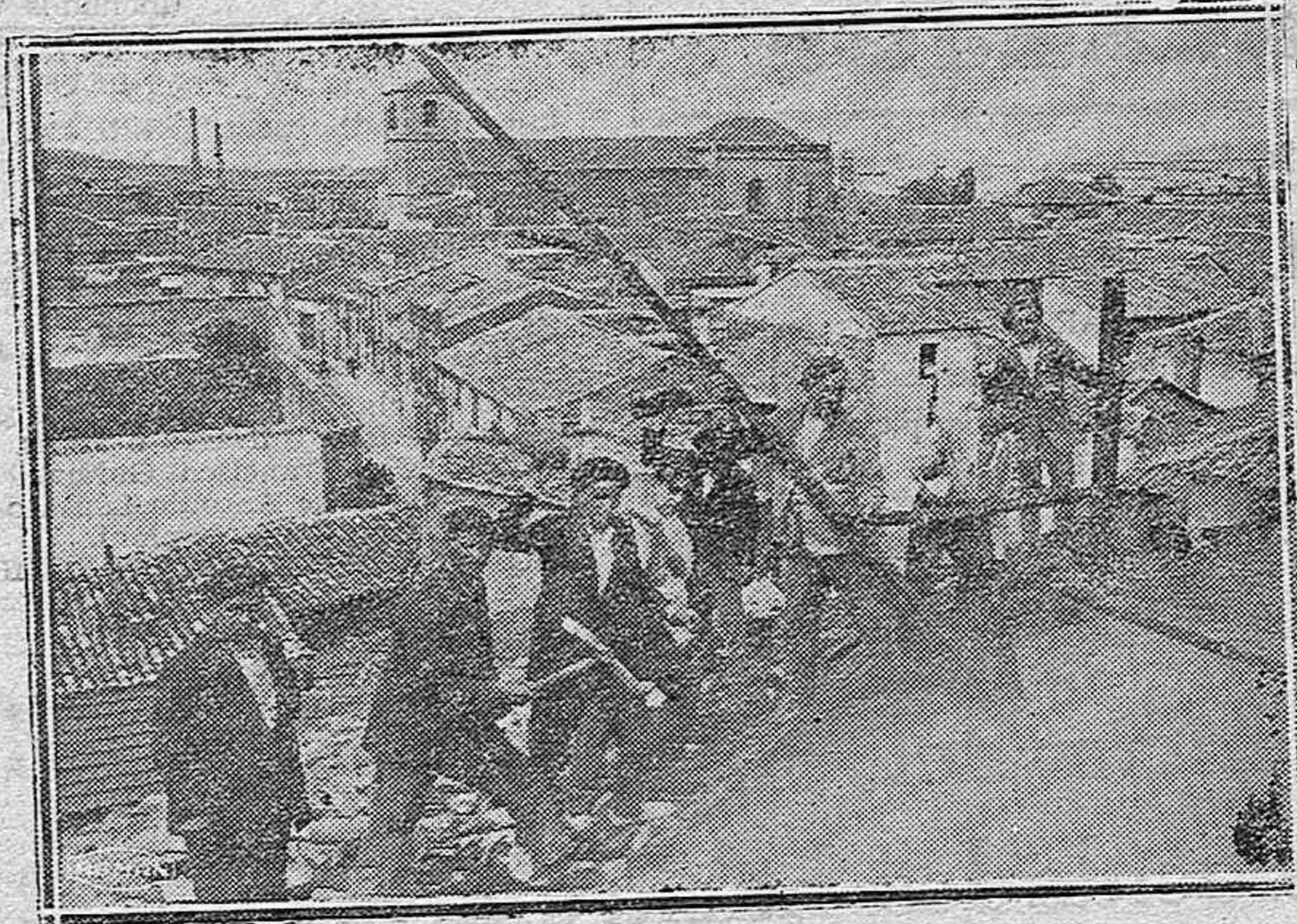
Personal del servicio de incendios trabajando bajo la dirección del Sr. Unamuno. (Foto Guzmán de Rego)
