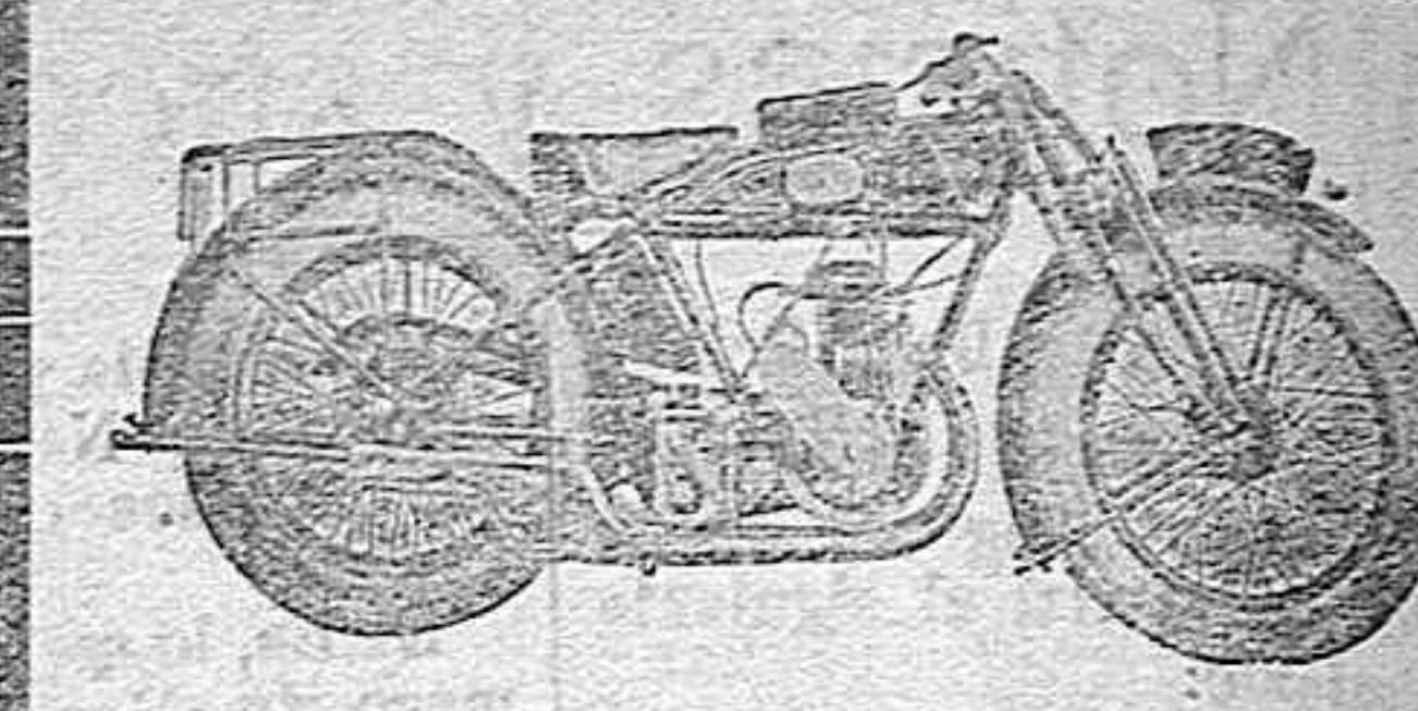
van equipadas con una caja de cambios AUTOMOTO, que permite el paso de una velocidad a otra con facilidad sorprendente, al mismo tiempo, sin acortar la marcha, cualquiera que sea la velocidad de la motocicleta, con o sin embrague.
