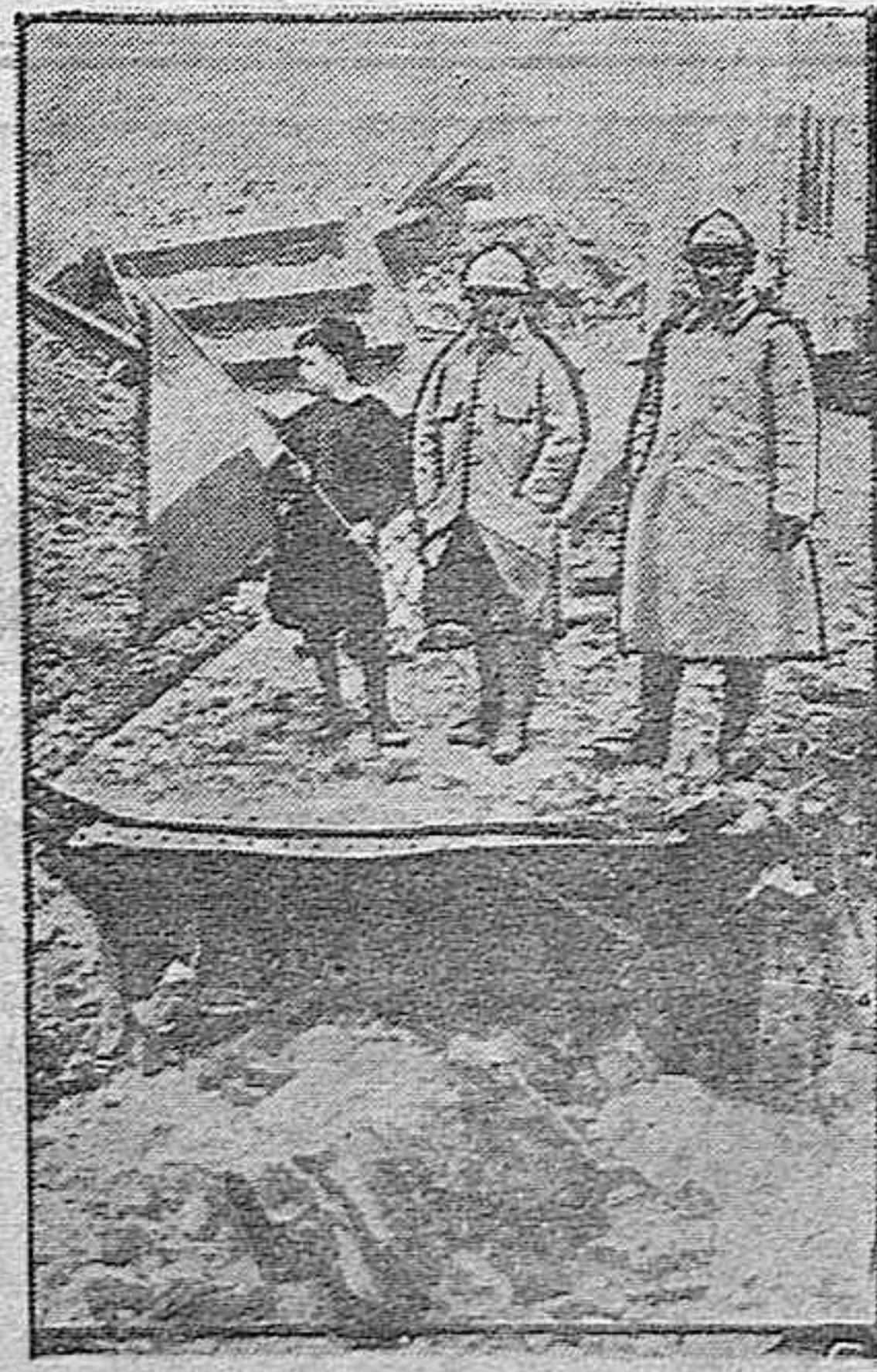
Puente del ferrocarril de Roye des-
