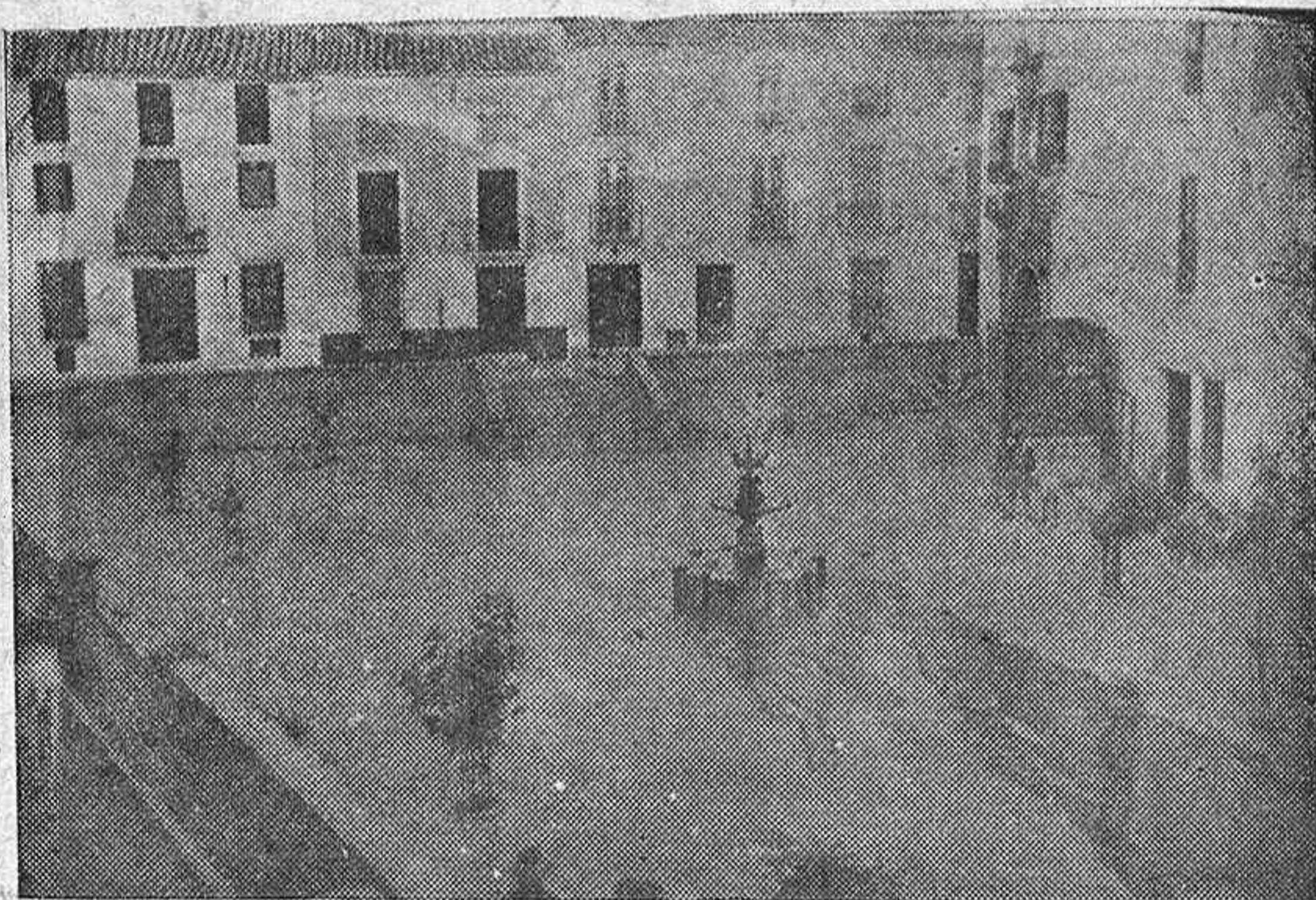
PRIEGO.—Nueva Plaza de San Pedro, obra recientemente terminada.
