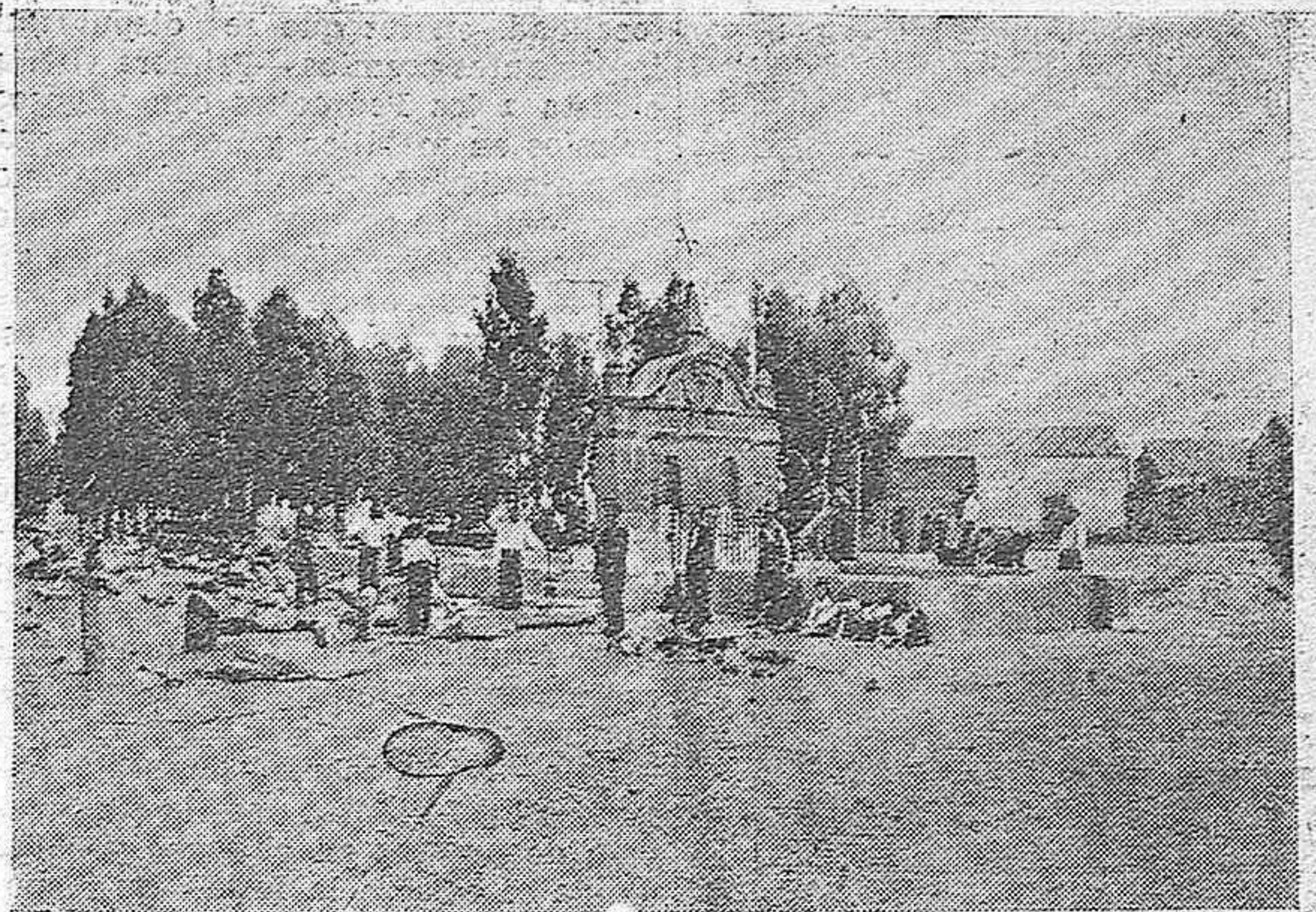
HINOJOSA DEL DUQUE.—La Fuente del Pilar que se está reformando, para acoplamiento de aguas potables.
