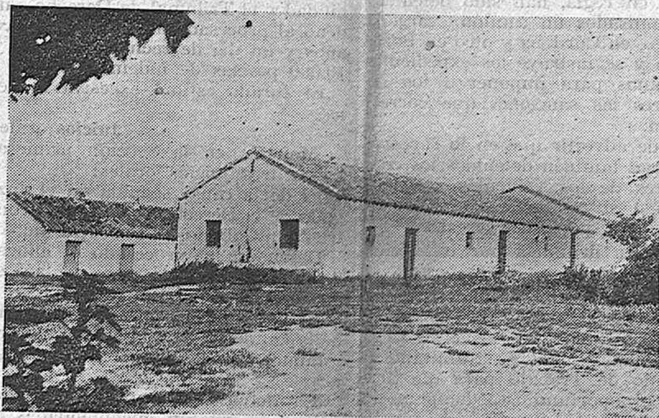
Vista de uno de los pabellones destinados a dormitorios que serán reformados por la Excm. Diputación provincial
