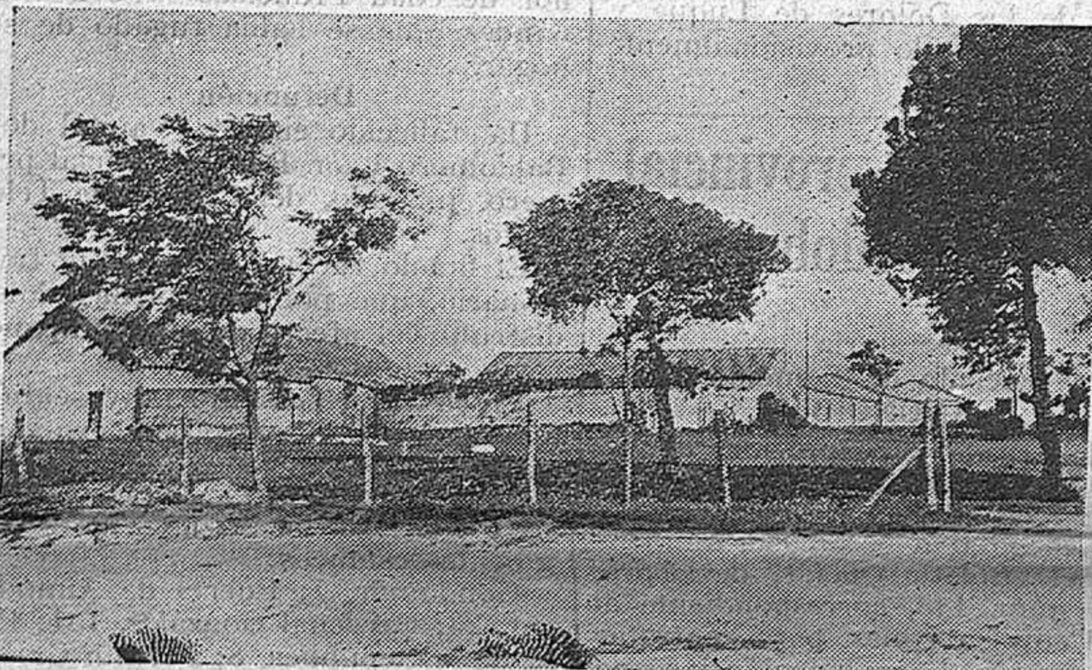
Vista general de la Colonia de altura en Cerro Muriano
