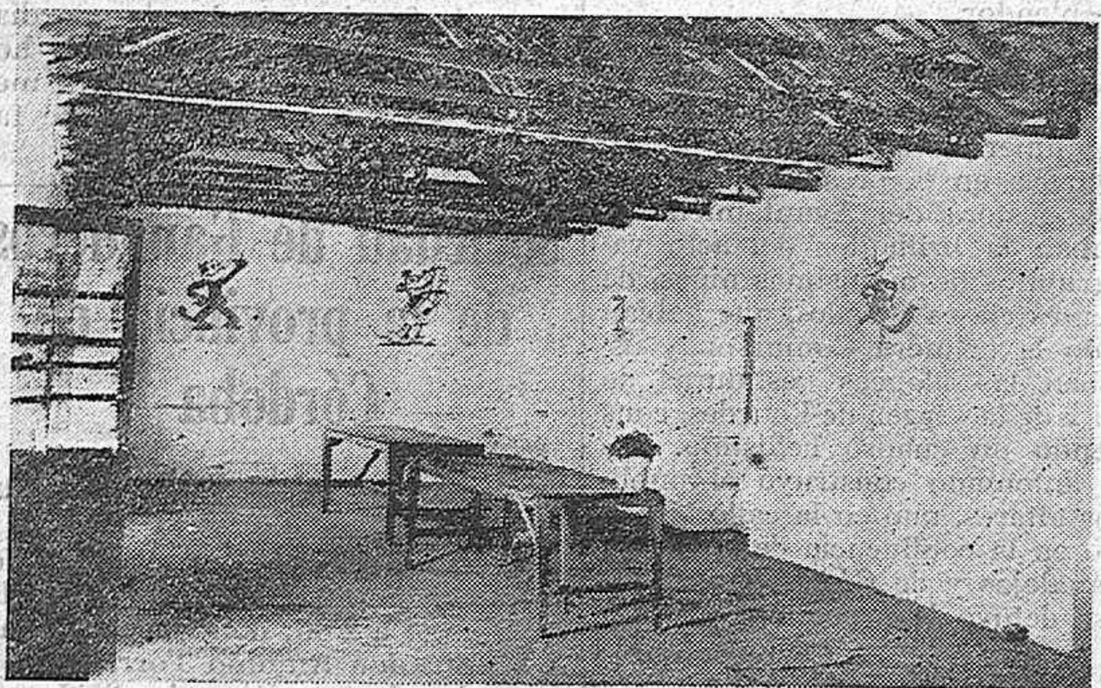
Un detalle del estado actual del amplio comedor
