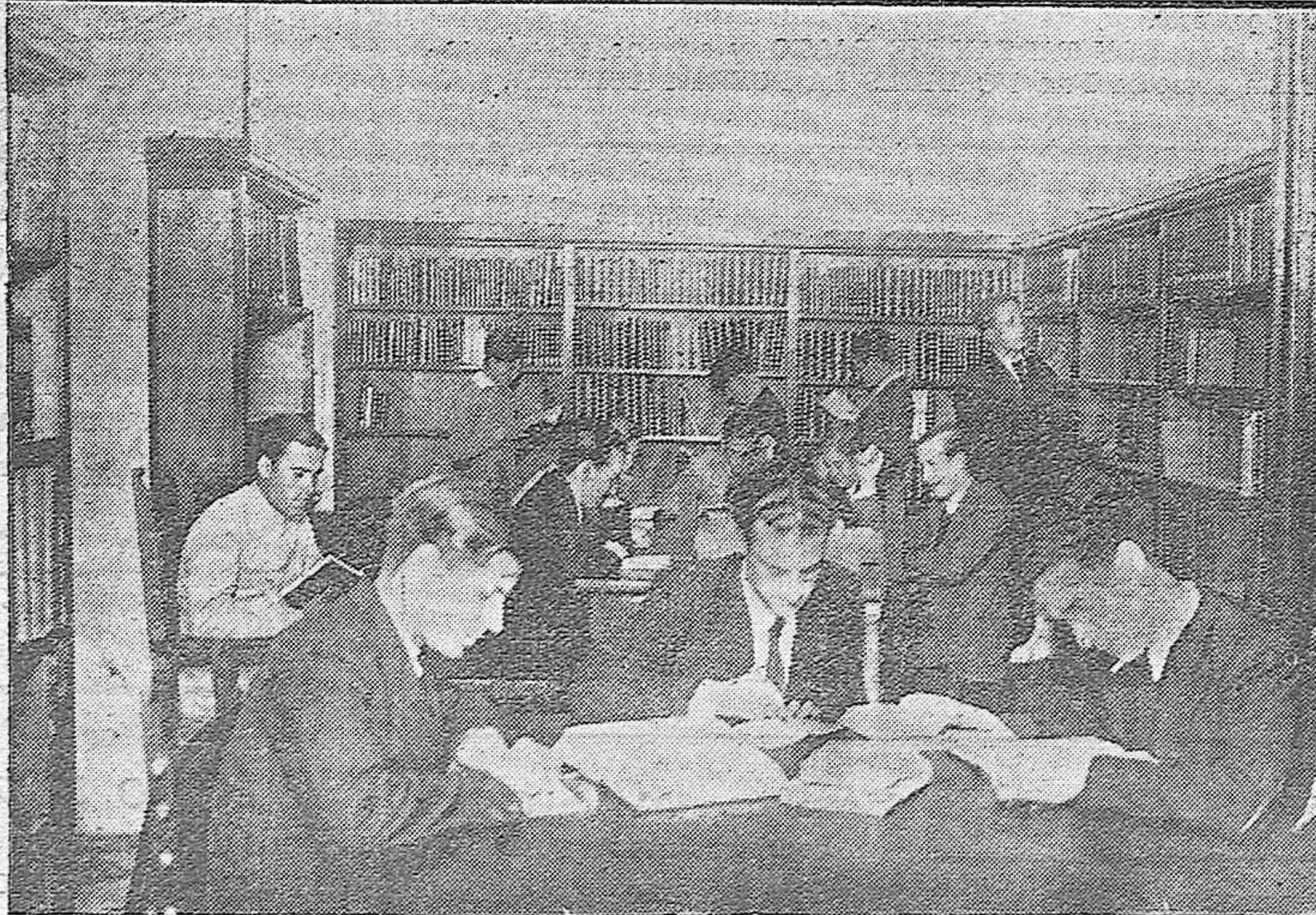
La Biblioteca Pública instalada en la parte baja de la Diputación Provincial a la que asisten diariamente gran número de estudiantes.—Dos aspectos de los salones de lectura
