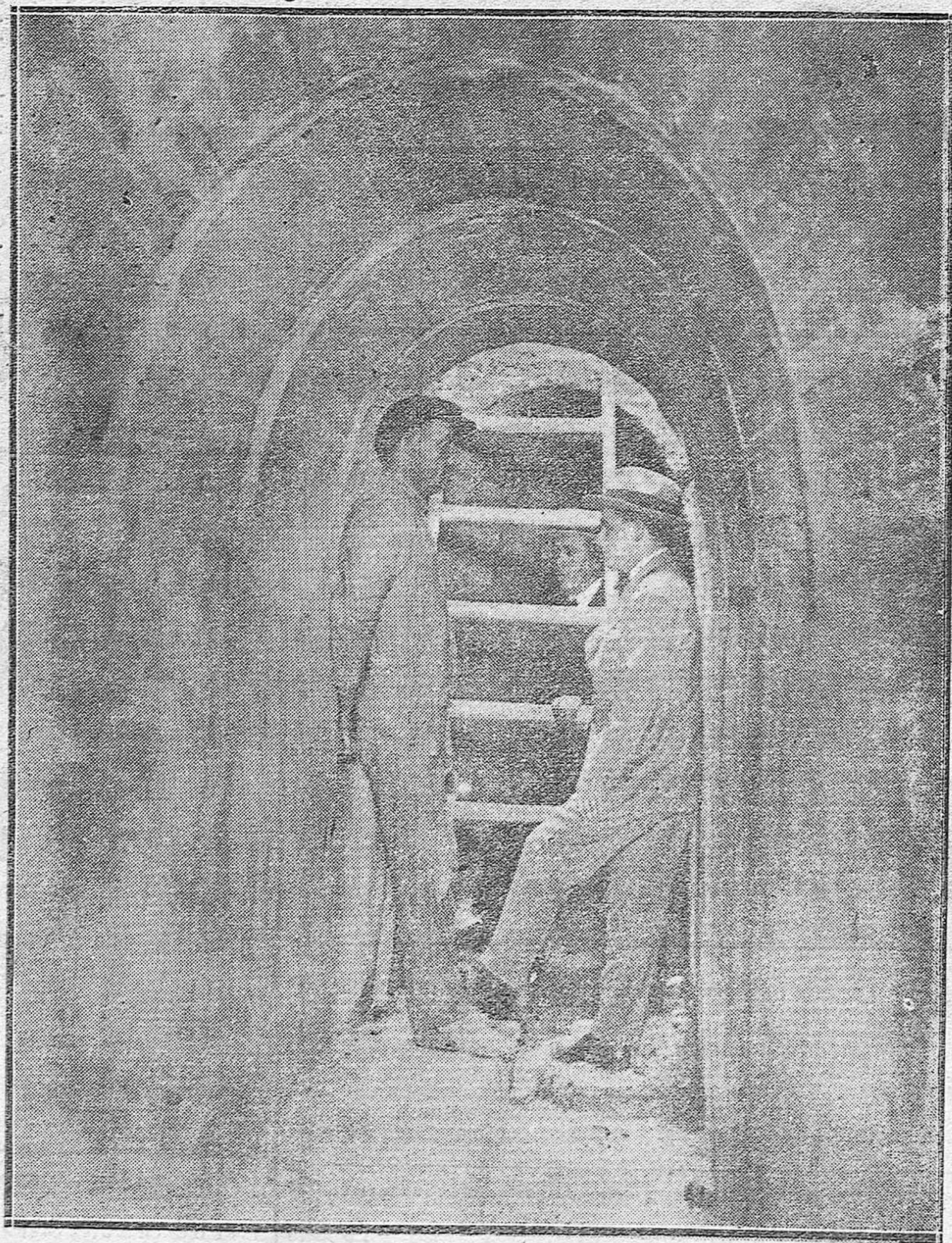
EL NUEVO ALCANTARILLADO.—EL INGENIERO CONSTRUCTOR DON LUIS DE ANSORENA, ACOMPAÑADO DE SU AYUDANTE Y DEL CAPATAZ EN UNA DE LAS ENTRADAS DE LA NUEVA ALCANTARILLA PRACTICABLE QUE UNE EL GRAN CAPITÁN (CON LA ANTIGUA DEL BUEN PASTOR.
