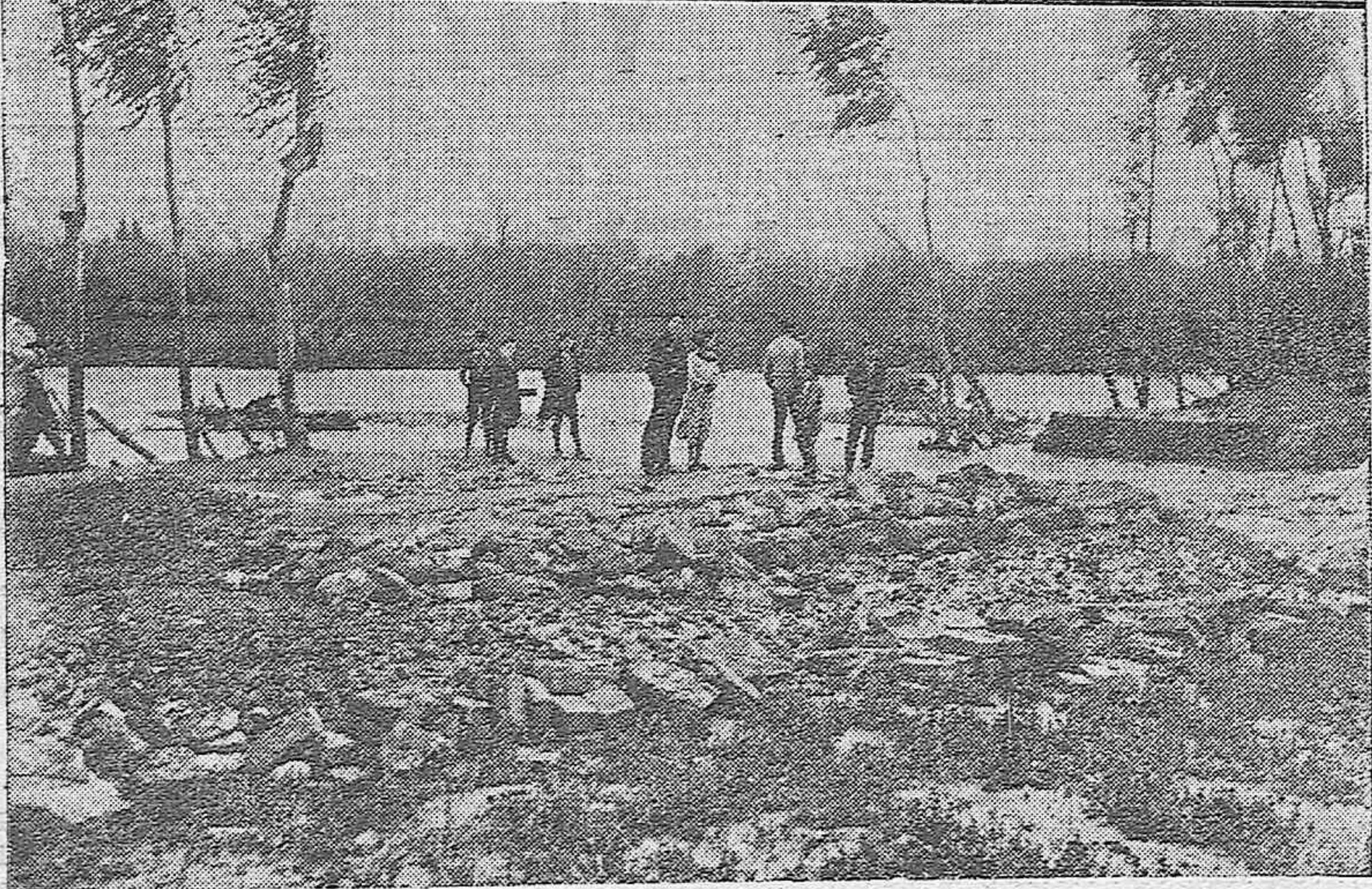
Arriba: Se celebró la Asamblea en la Sociedad Deportiva de Caza y Pesca, siendo elegida la nueva Junta Directiva para el año actual.—Abajo: A causa del pasado temporal y viento huracanado se hundió un muro, cortando la carretera y el puentecillo en el camino del Arenal, próximo a la barriada de La Fuelsanta
