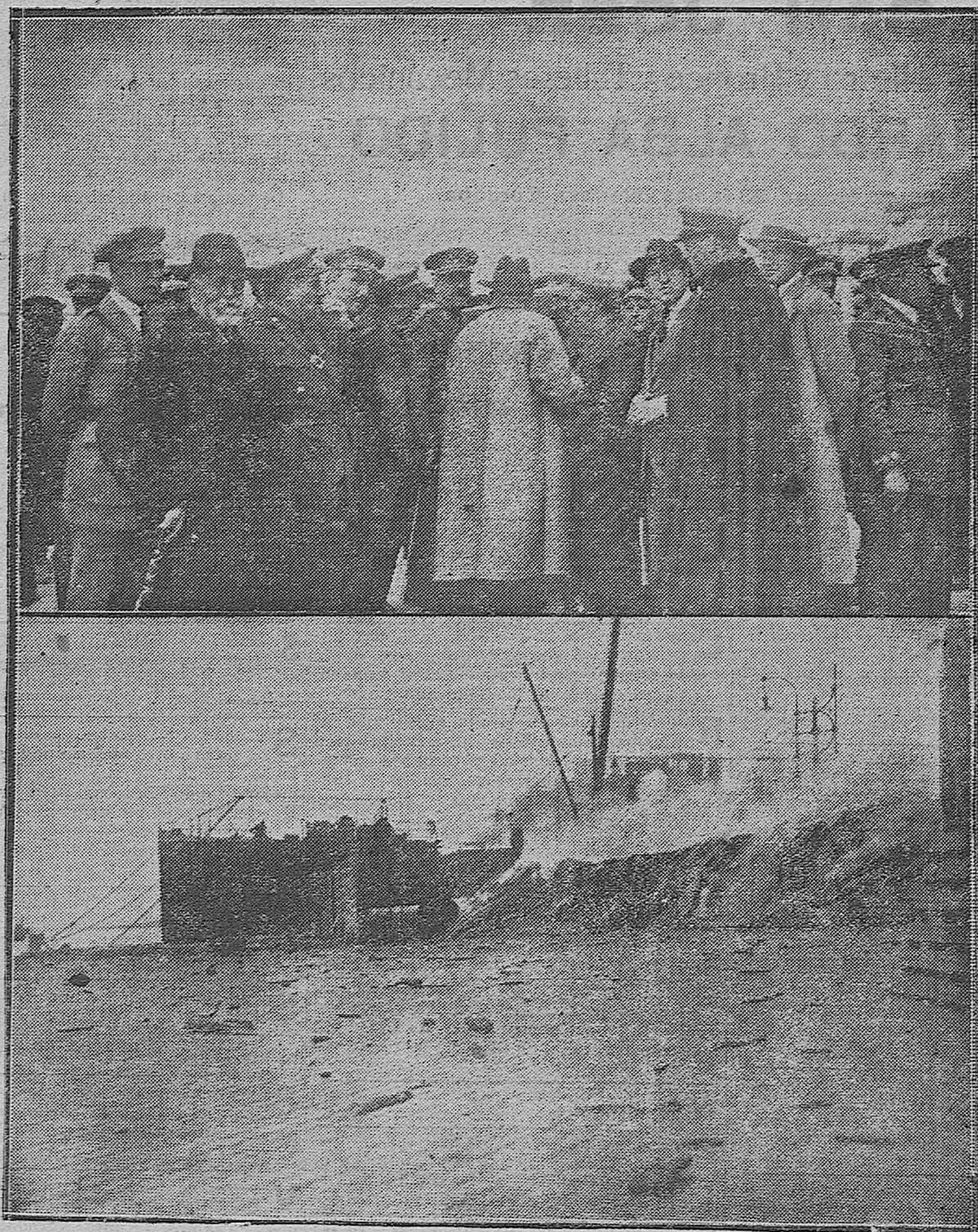
LA EXPLOSION DE MATERIAL DE GUERRA EN EL PUERTO DE MELILLA.—1) El general Sanjurjo y todas las autoridades de la plaza, en los primeros momentos, tomando las medidas y dando las oportunas disposiciones que atajaron el siniestro.—2) Vista del lugar del siniestro durante las explosiones y el incendio.
