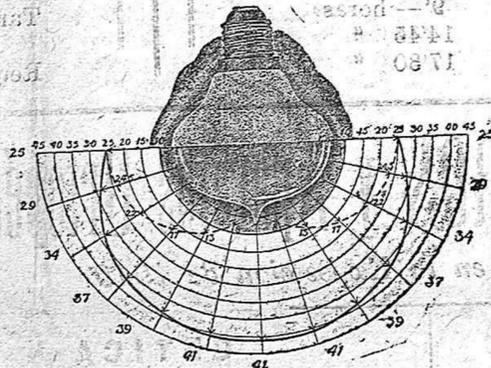
El filamento de tungsteno no está montado verticalmente de arriba a bajo, sino en forma espiral, por lo cual, todos los golpes son amortiguados y neutralizados. Por esto, la lámpara POPE forma espiral con reflector, prácticamente es
