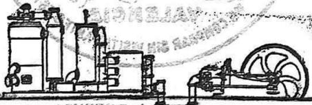
Gasógenos sistema Crossley, sin gasómetro ni caldera.—Gasógenos sistem:
