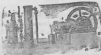
en combinación con aparatos para gas pobre, sin caldera, sin gasómetro. Sistema por aspiración.
