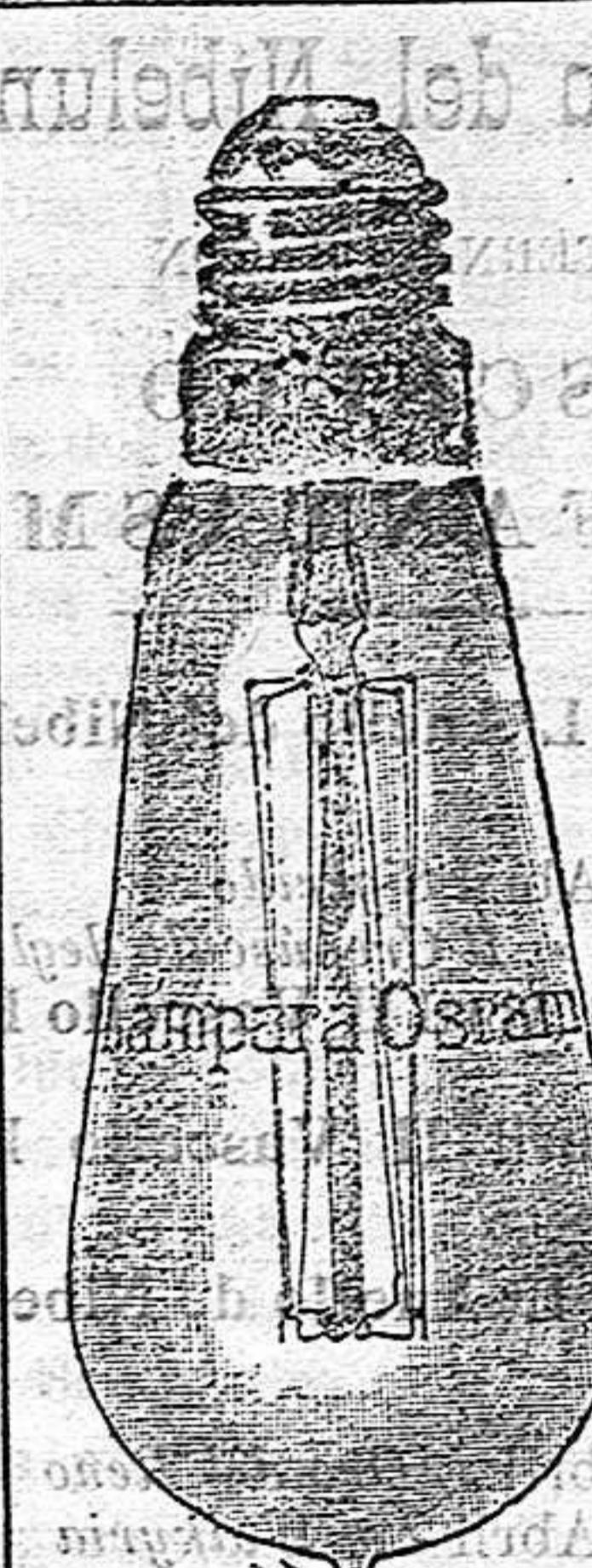
La lámpara Osram consume solo 1 vatio por bujía, ó sea la tercera parte que una lámpara corriente.
