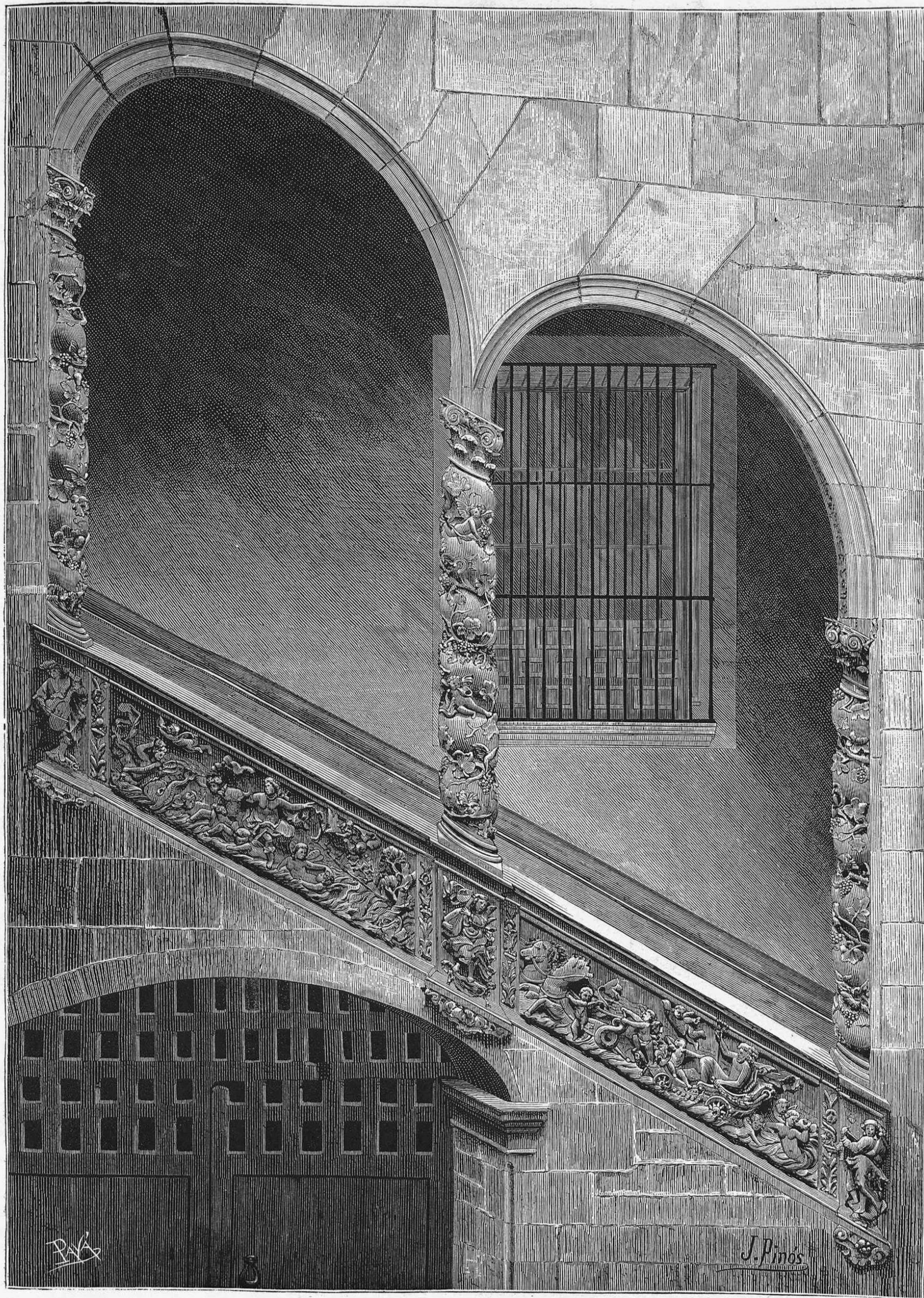
ÈSCALA NOBLE DE LA CASA DE DALMASES EN LO CARRER DE MONCADA EN BARCELONA
