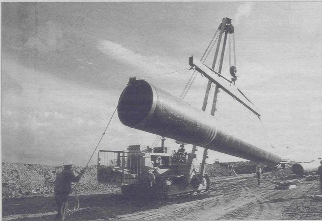
Una imagen de la instalación de la tubería del gasoducto, en una imagen de archivo. / GAS NATURAL
