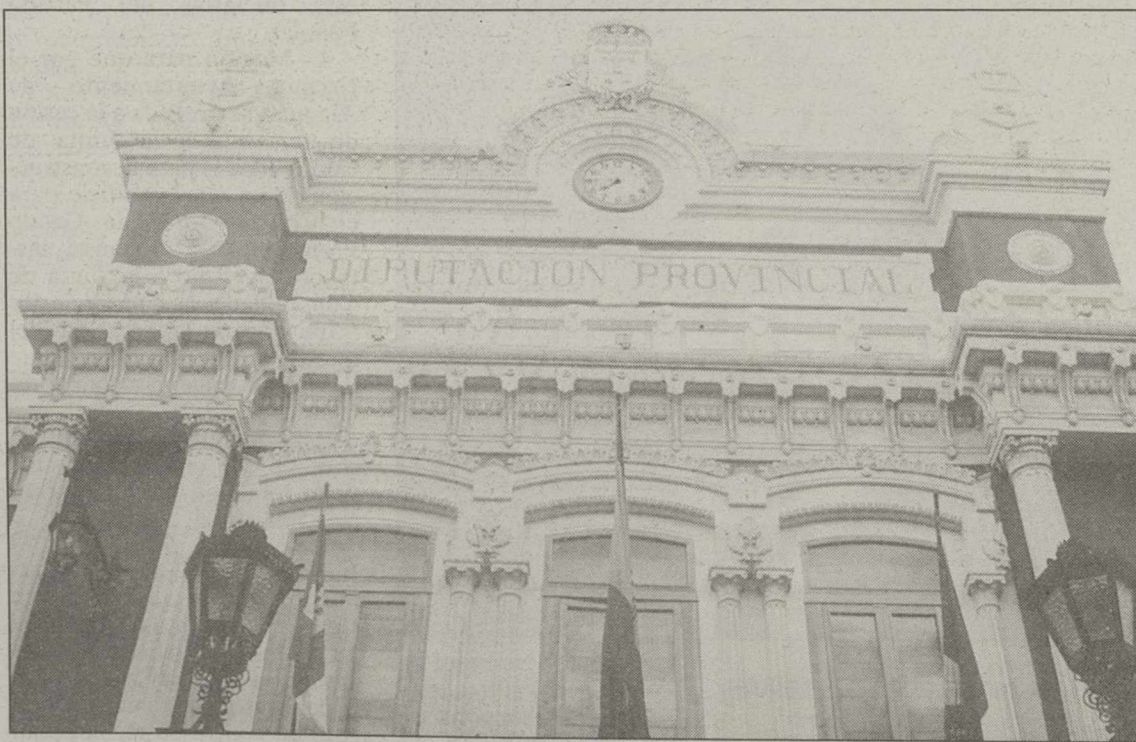
Las obras están a cargo de la Diputación.
