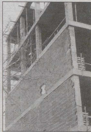
Vivienda en construcción. A.
