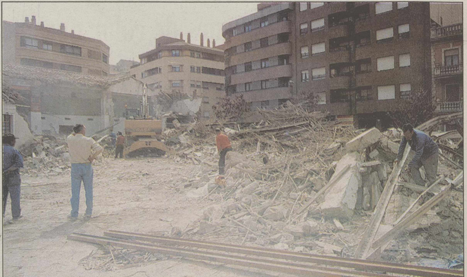
La demolición del edificio de la Antigua Central se ha quedado a medias y sin vigilancia, según los vecinos.
