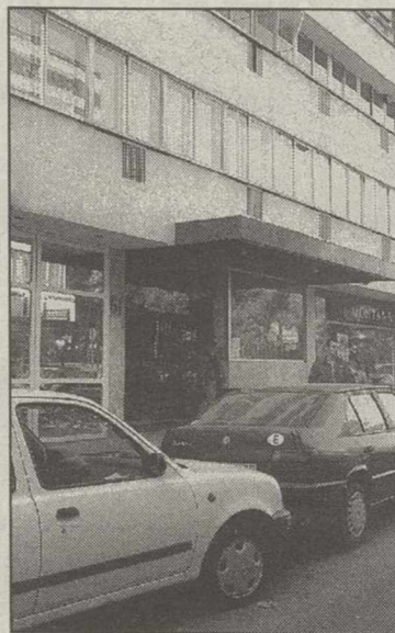
Fachada del edificio madrileño.
