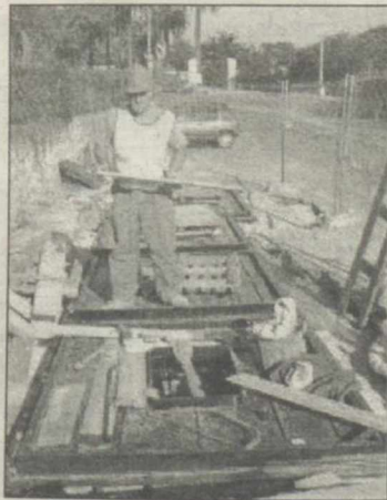
Obras en Santander
