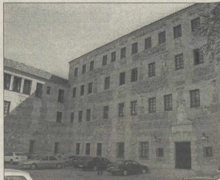
Sede las Cortes de Castilla-La Mancha
