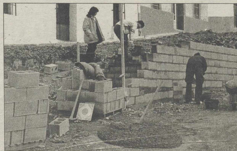
Estado de las obras que están siendo realizada a la entrada.
