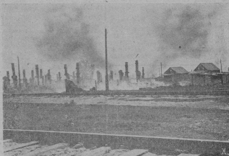
Una estación férrea de Stalingrado en el estado que la encontraron los alemanes al ocuparla, después de una lucha sangrienta. Los so- viets, antes de huir, incendiaron todas las instalaciones
