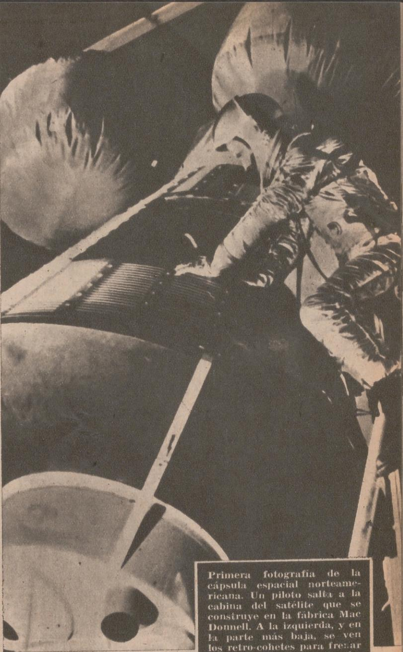
Primera fotografía de la cápsula espacial norteamericana. Un piloto salta a la cabina del satélite que se construye en la fábrica Mac Donnell. A la izquierda, y en la parte más baja, se ven los retro-cohetes para frenar el vehículo, y sobre el piloto, los sacos de flotación para que la cápsula flote y se estabilice en el agua.
