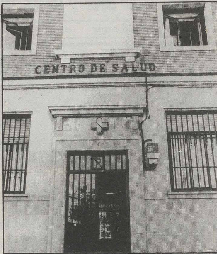
Fachada del Centro de Salud norte
