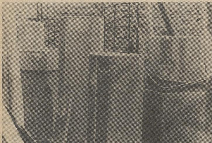
Las seis grandes columnas, sin otro valor que el de su espectacularidad, fueron desmontadas para la colocación del forjado. Posteriormente volverán a ser instaladas, aunque ligeramente desplazadas con respecto al lugar que ocupaban.
