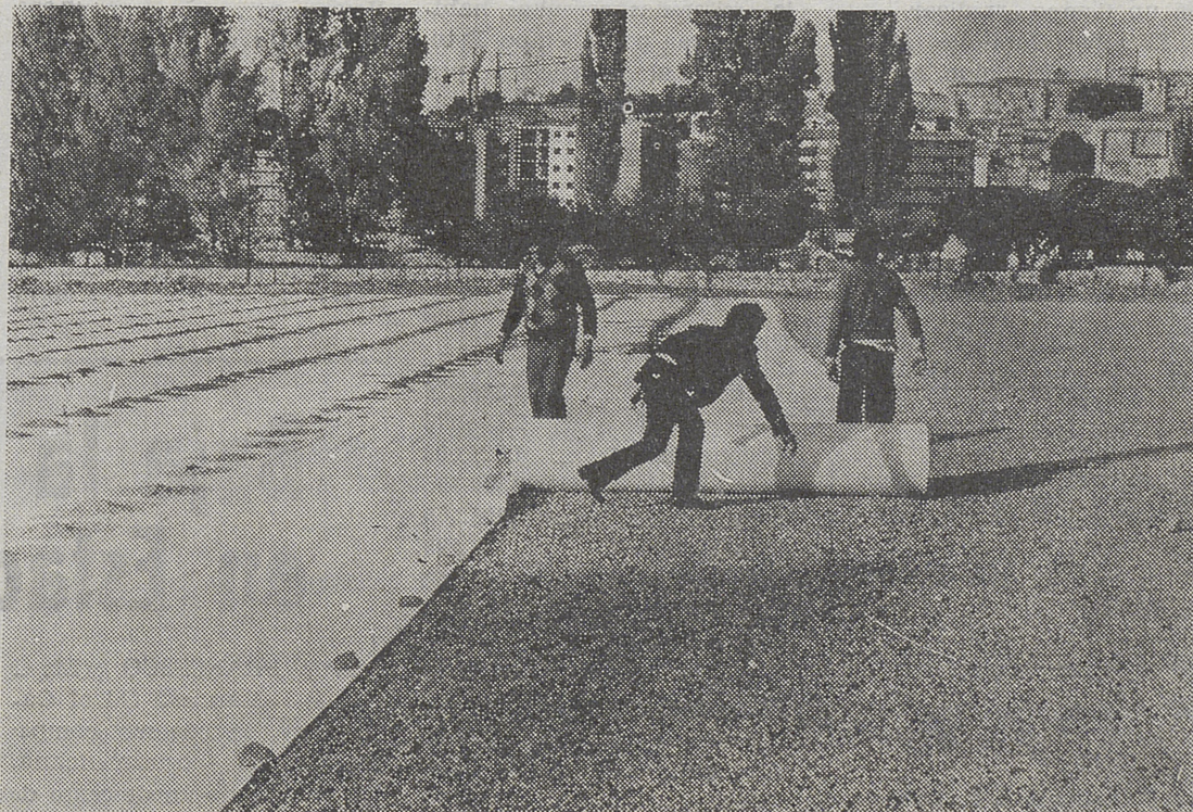
En uno de los dos campos de fútbol que se están construyendo a ambos lados del estadio «Adolfo Suárez», se han extendido ya unas bandas de fieltro, hasta cubrir la totalidad de lo que será terreno de juego, con el fin de evitar que se filtre tierra en el drenaje, lo que redundará en beneficio de la calidad y duración de la futura cancha.
