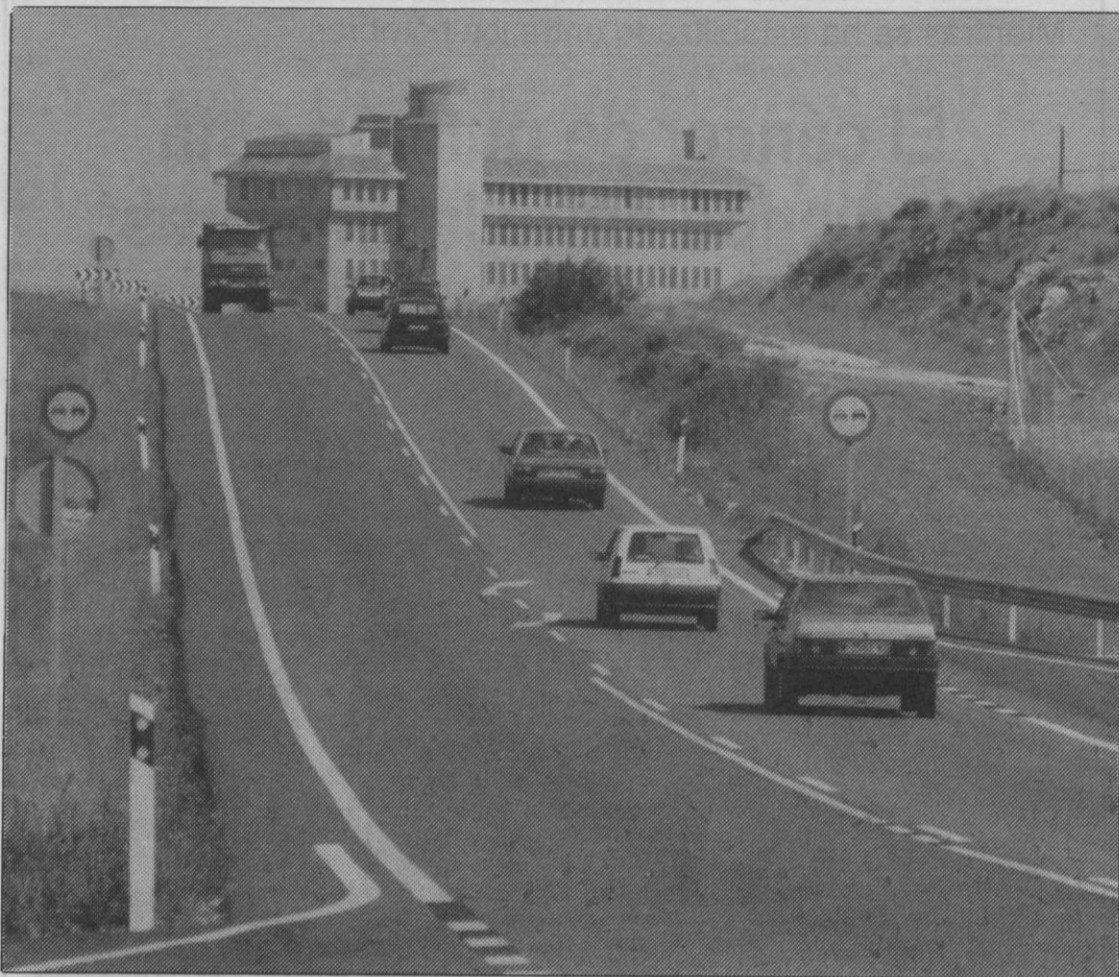
La aprobación supone un paso adelante en la construcción de esta importante vía.
