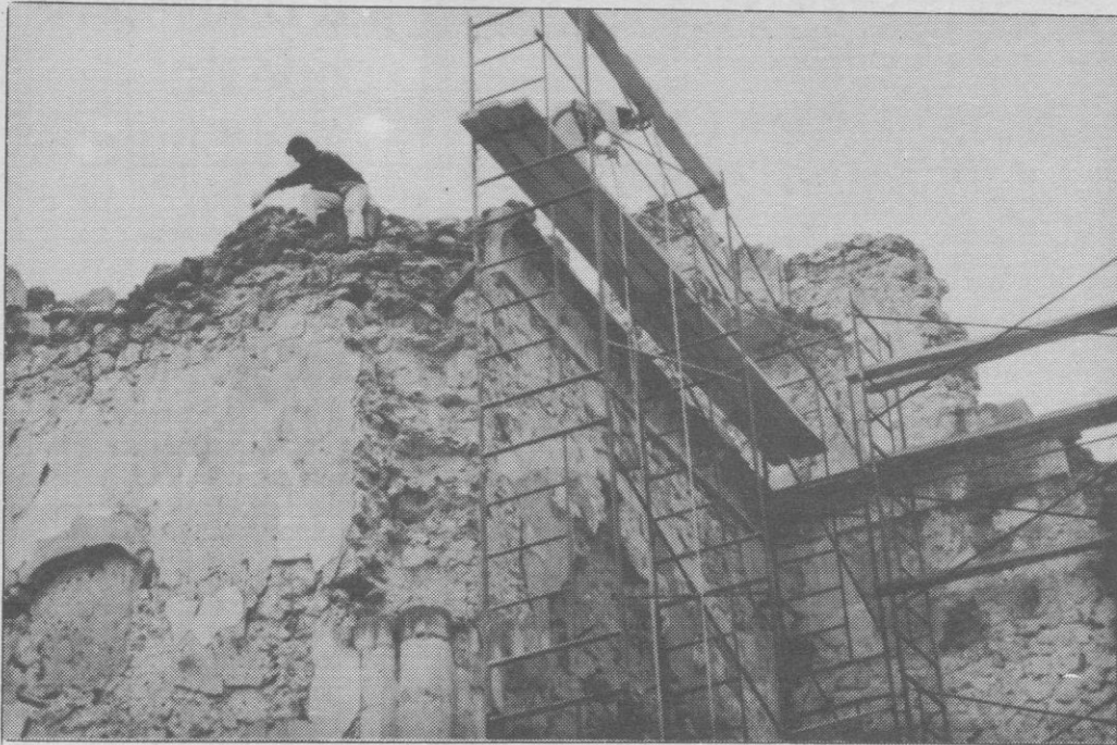
Obras en los muros de los ábsides.
