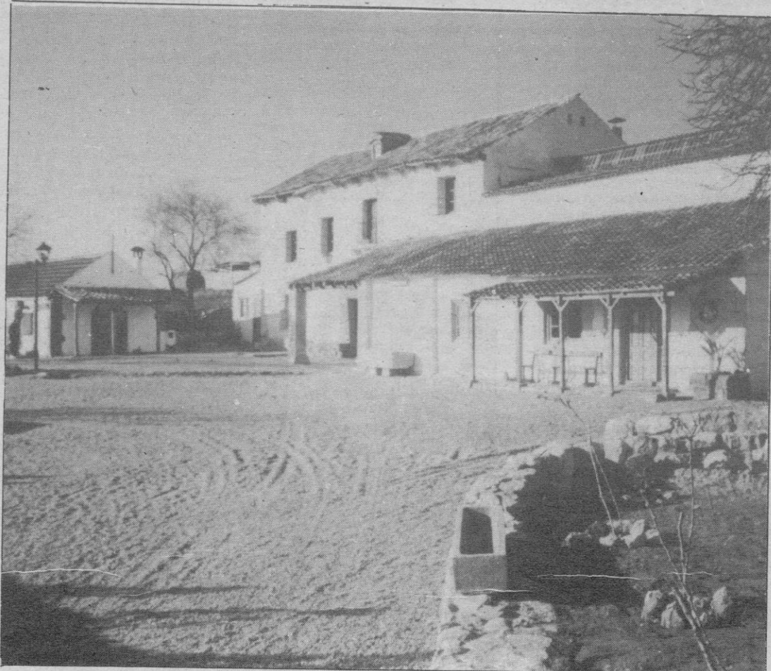
Vista del centro de rehabilitación «El Solano», en Valladolid
