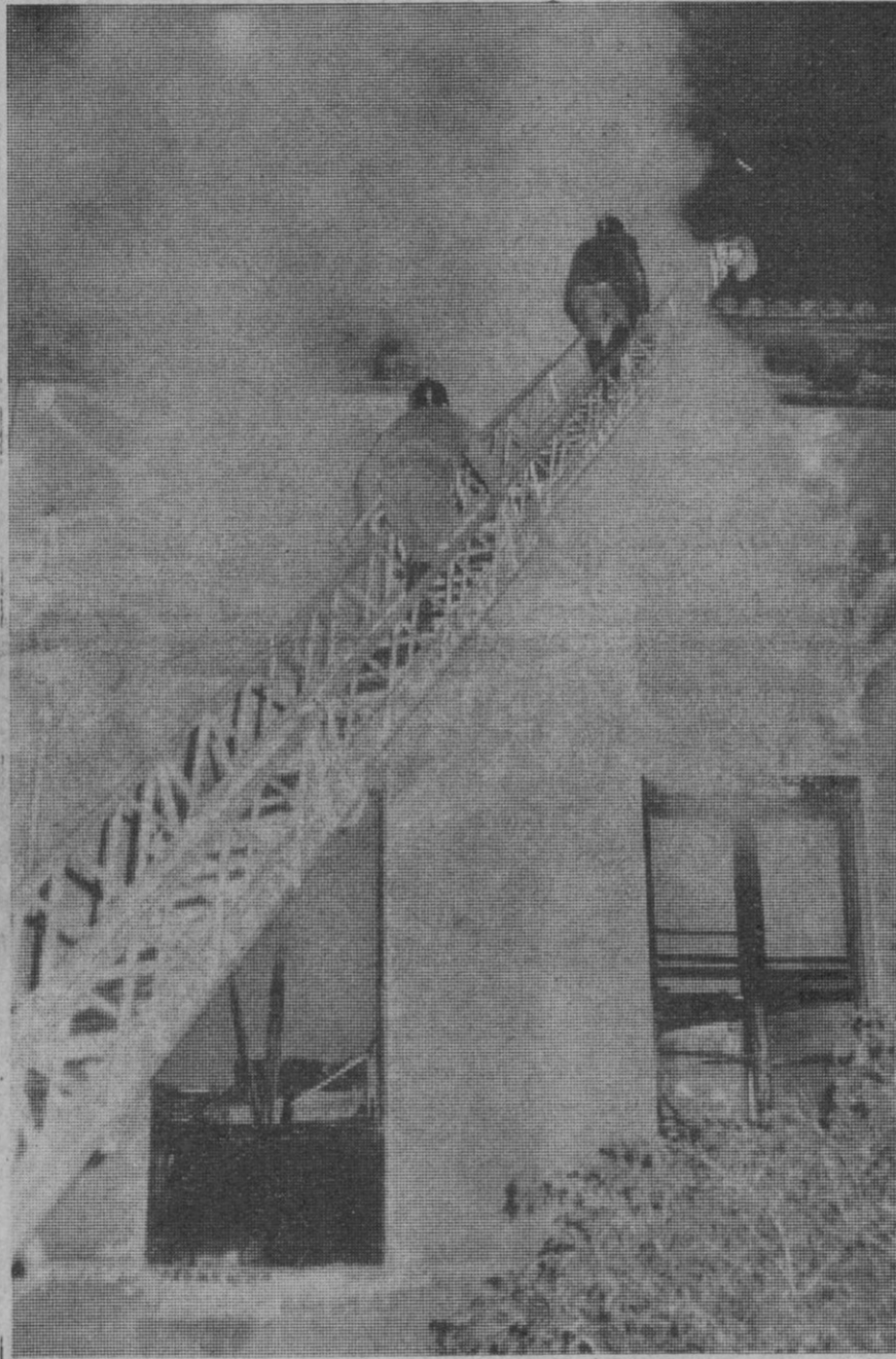
Madrid.—Los bomberos trabajando en la extinción del incendio de los pisos superiores del edificio de la Universidad de San Bernardo. El siniestro comenzó sin que, por el momento, se conozcan las causas. Doce coches del servicio contra incendios trabajaron en la extinción del mismo.
