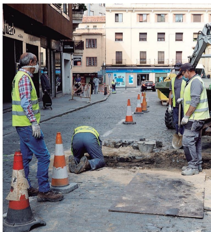
Los operarios trabajan en el arreglo de la tubería rota.
