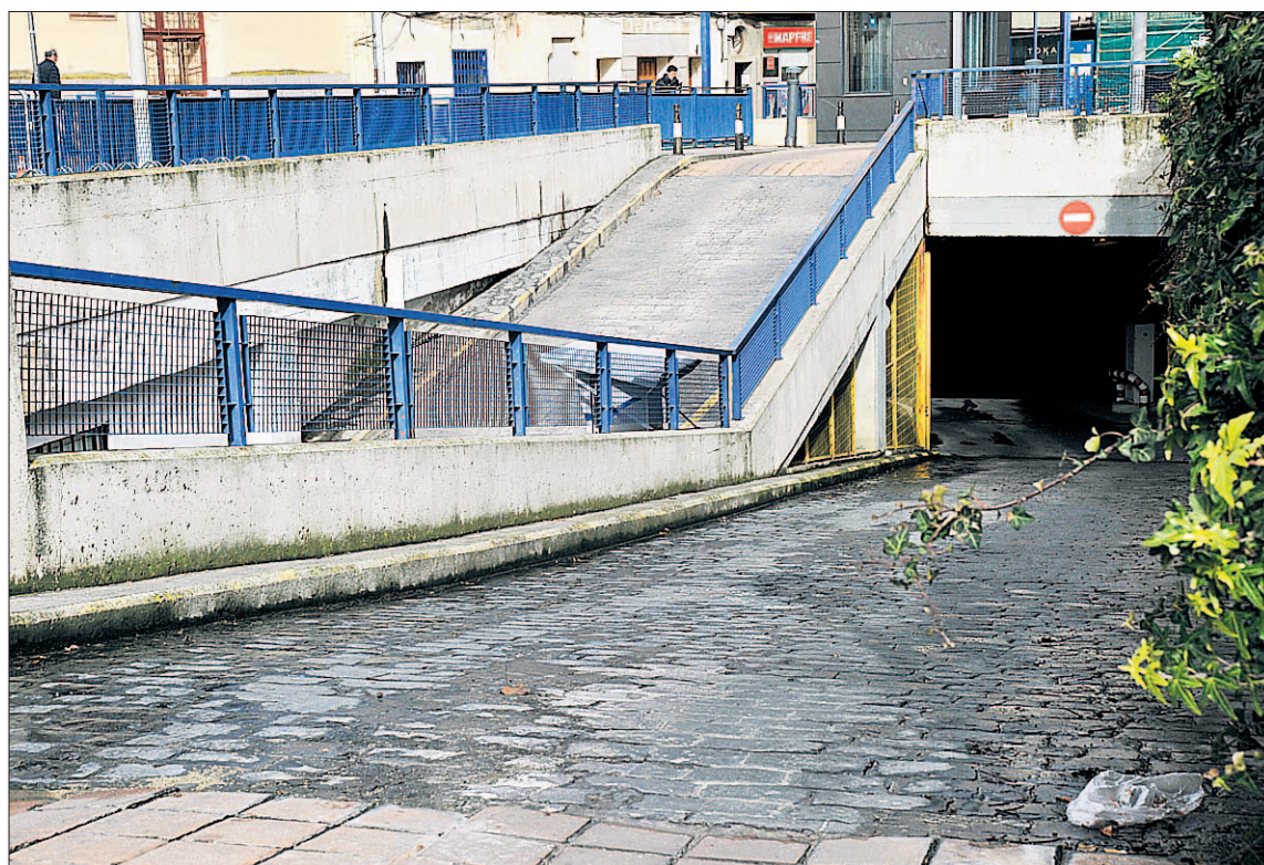
La intervención incluye la impermeabilización de la rampa de salida del aparcamiento. / KAMARERO
